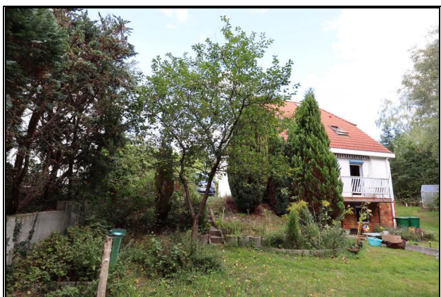
Süd-West-Ansicht des Wohnhauses mit Teil der Außenanlagen
