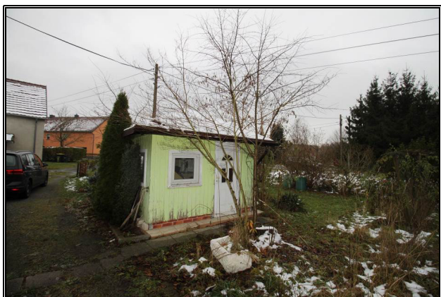
Nord-Ansicht des Gartenhäuschens als Teil der Außenanlagen
