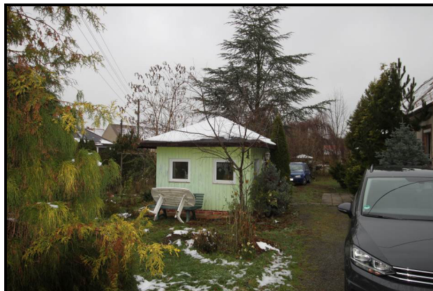
Süd-Ost-Ansicht des Gartenhäuschens als Teil der Außenanlagen
