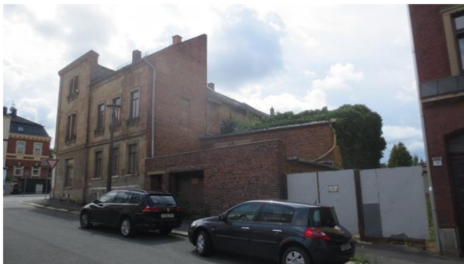
Foto 4: Nordansicht von der Schrödelstraße mit verschlossener Grundstückszufahrt
