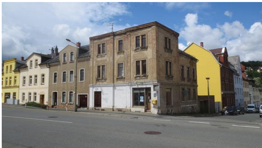
Foto 1: Südostansicht des Eckgebäudes
