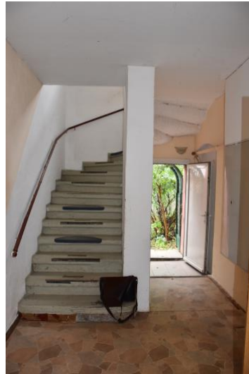
Foto 10: dto, mit Geschosstreppe
