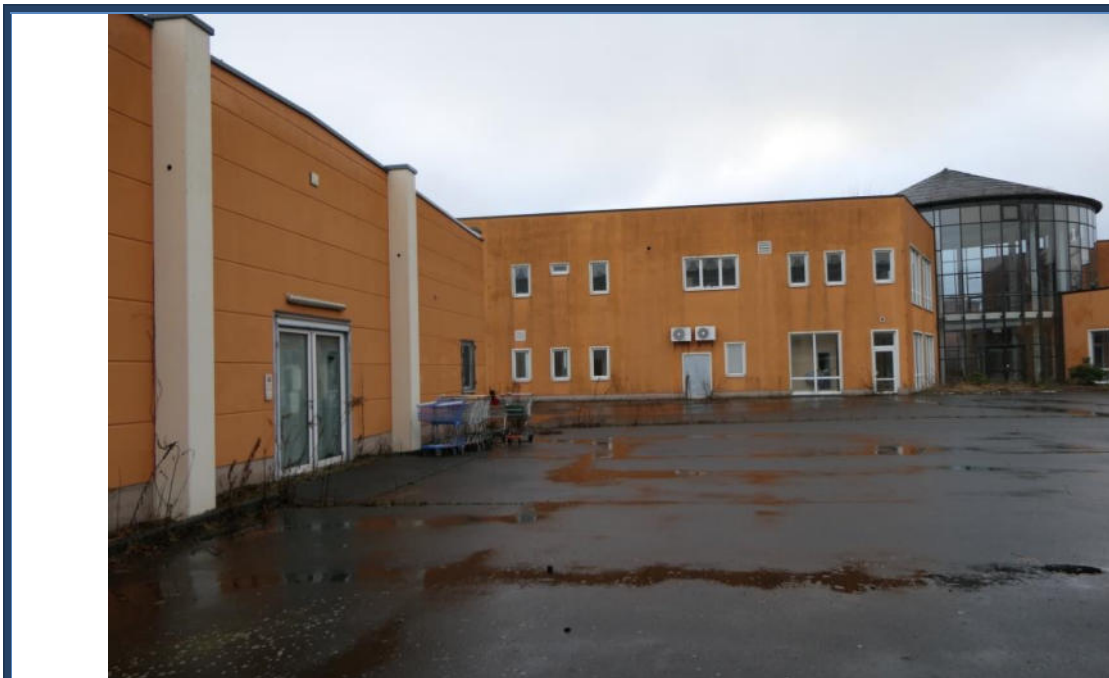
Abbildung 6: Nord-Ansicht des Einkaufszentrums (Rückansicht); links das Einzelhandelsgebäude; Außenanlagen
