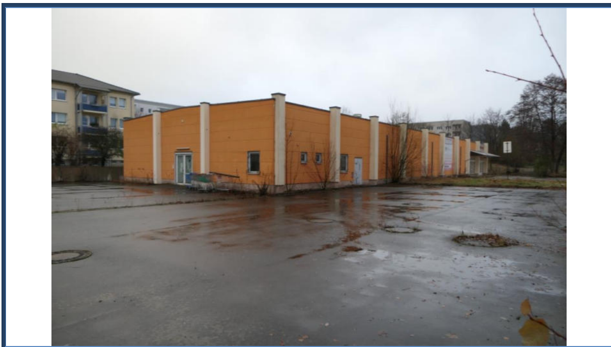
Abbildung 17: Süd-West-Ansicht des Einzelhandelsgebäudes (Vorder-/Seitenansicht); verwilderte Außenanlagen; umliegende Bebauung
