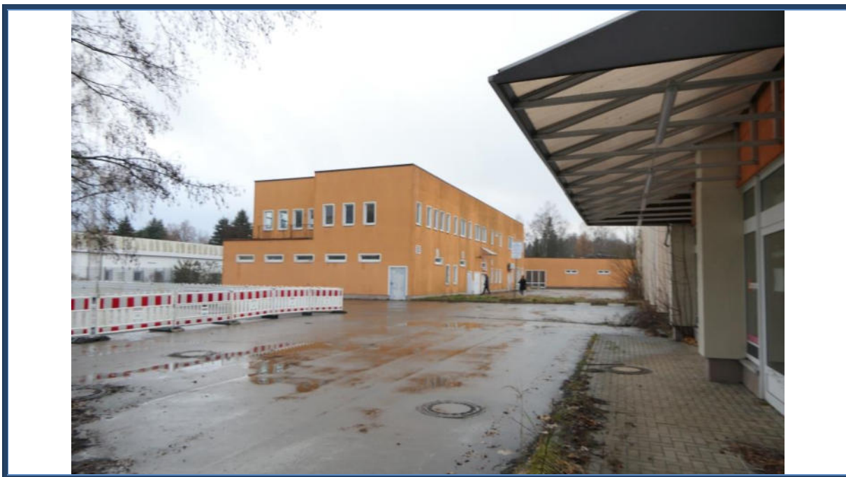
Abbildung 22: Außenanlagen im östlichen Grundstücksteil; links das Einkaufszentrum; rechts das Einzelhandelsgebäude
