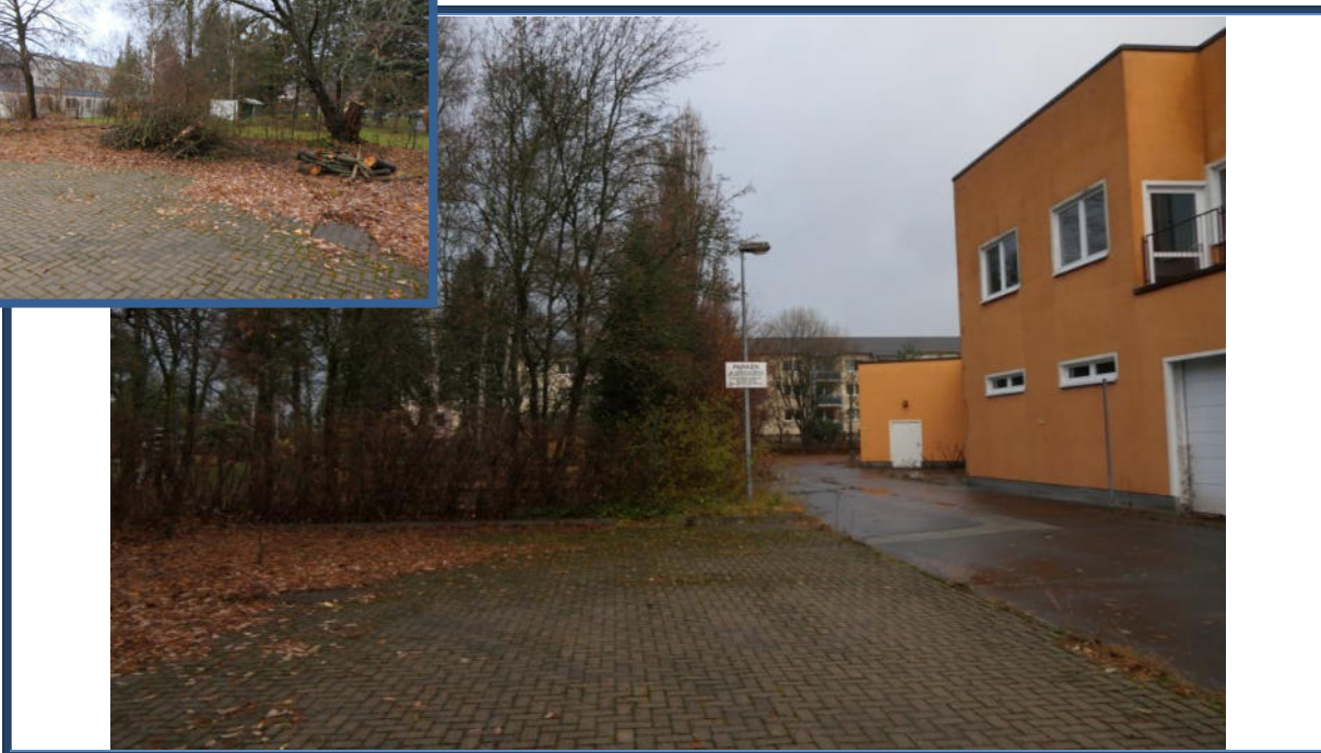
Abbildung 25: Verwilderte Außenanlagen im westlichen Grundstücksbereich; umliegende Bebauung
