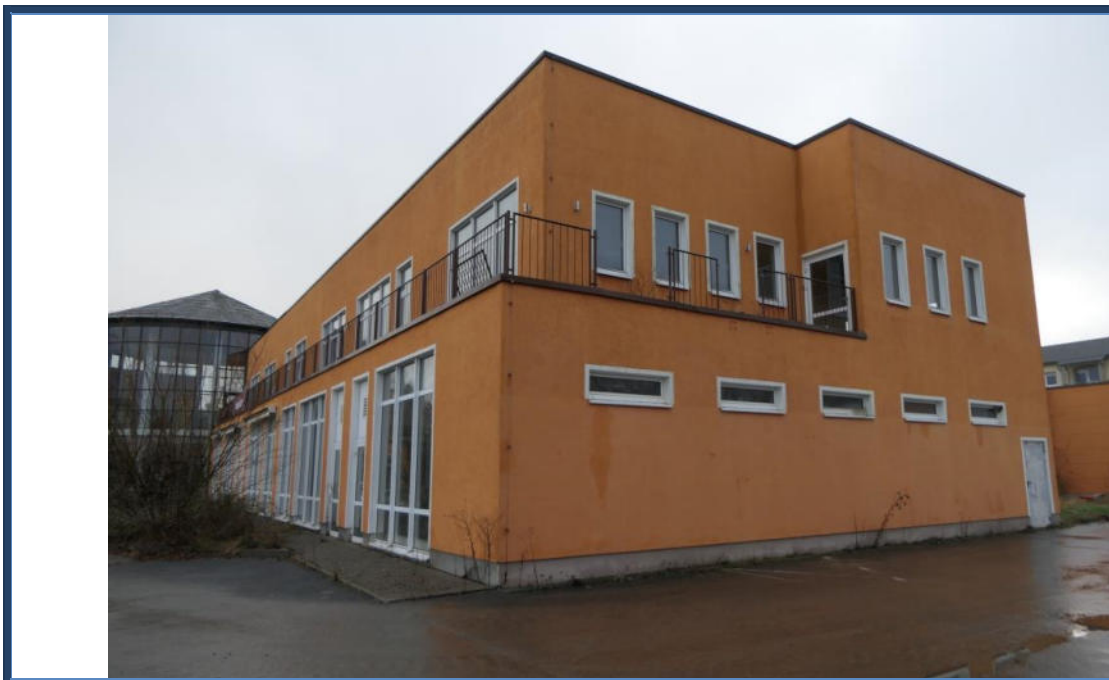
Abbildung 4: Süd-Ost-Ansicht des Einkaufszentrums (Vorder-/Seitenansicht); Außenanlagen
