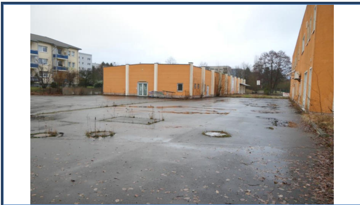
Abbildung 23: Außenanlagen im nördlichen Grundstücksteil; links das Einzelhandelsgebäude; rechts das Einkaufszentrum; umliegende Bebauung
