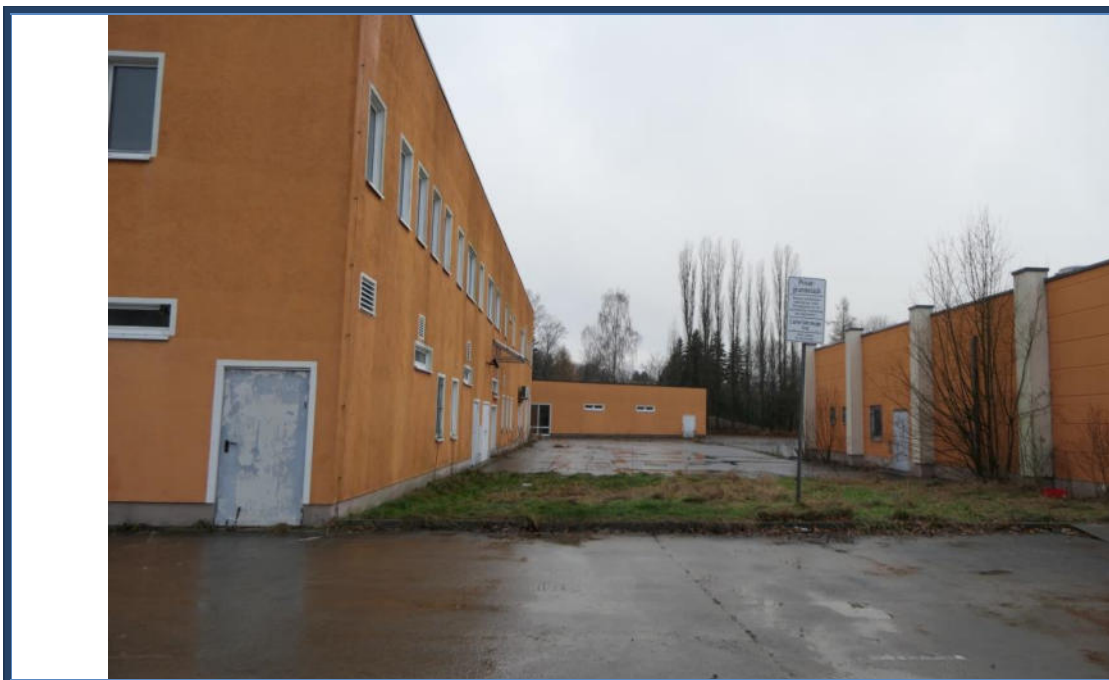
Abbildung 14: Verwilderte Außenanlagen im nördlichen Grundstücksteil; links das Einkaufszentrum; rechts das Einzelhandelsgebäude
