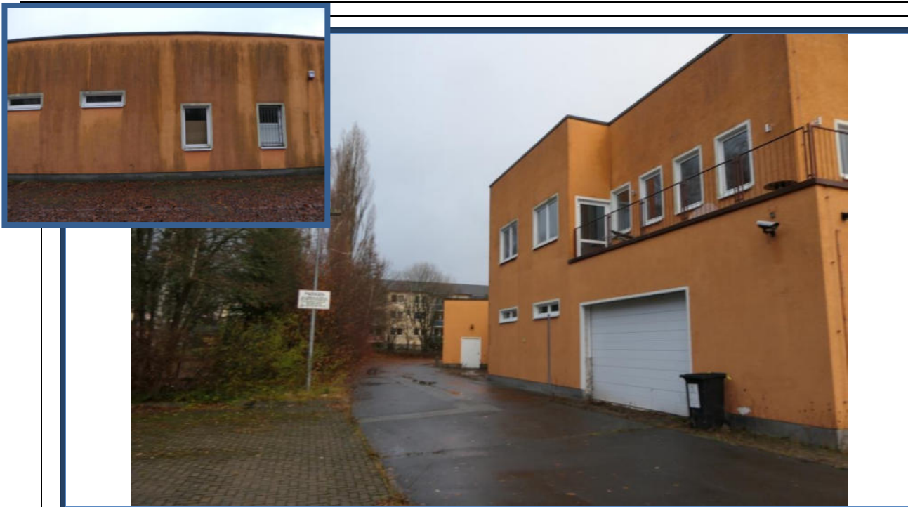
Abbildung 9: West-Ansicht des Einkaufszentrums (Seitenansicht); zum Teil stark verschmutzte Fassade; verwilderte Außenanlagen
