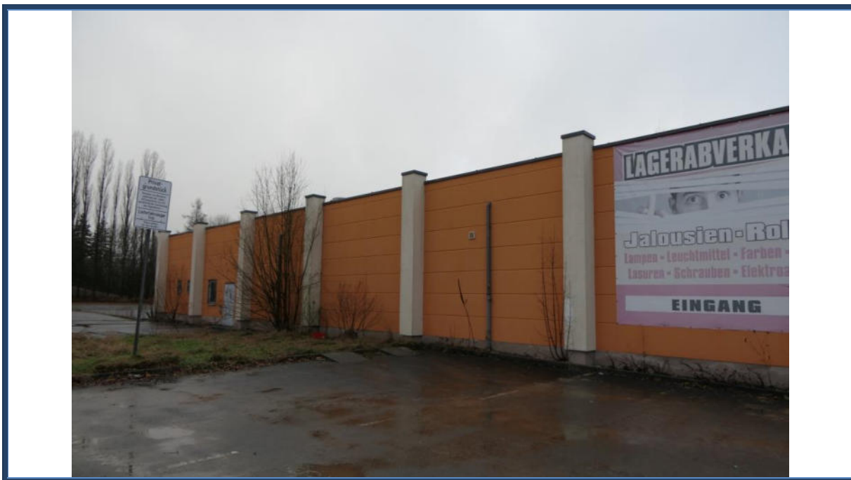
Abbildung 18: Süd-Ansicht des Einzelhandelsgebäudes (Vorderansicht); verwilderte Außenanlagen
