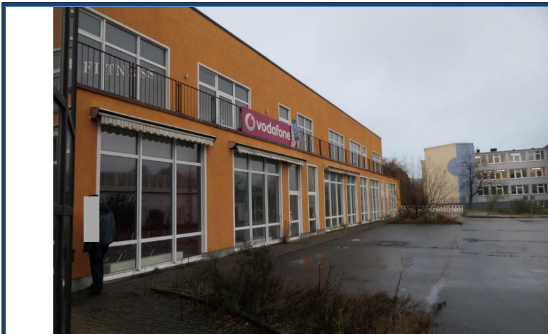
Abbildung 2: Süd-Ansicht des Einkaufszentrums (Vorderansicht); Außenanlagen; umliegende Bebauung (Schule); verwilderte Außenanlagen
