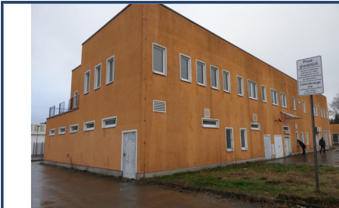
Abbildung 5: Nord-Ost-Ansicht des Einkaufszentrums (Seiten-/Rückansicht); verwilderte Außenanlagen
