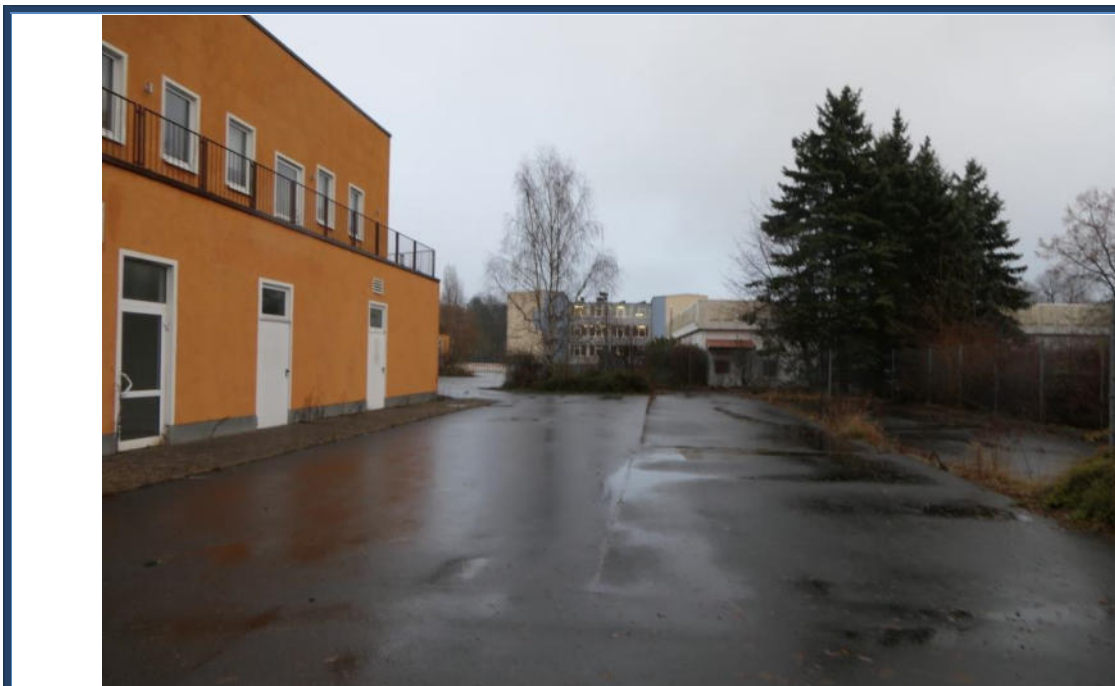
Abbildung 13: Parkplätze und Außenanlagen im südlichen Grundstücksteil; umliegende Bebauung
