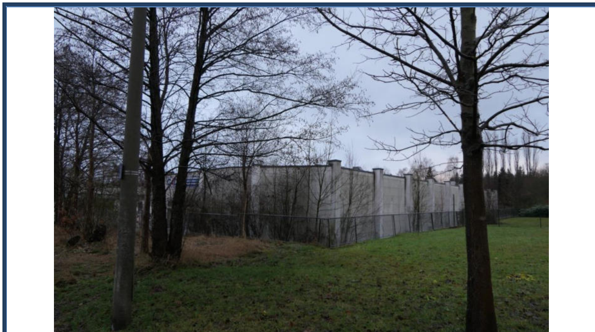
Abbildung 20: Nord-Ost-Ansicht des Einzelhandelsgebäudes (Rückansicht)
