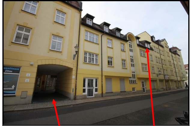
Zugang zum Innenhof; Lage der Wohnung Nr. 6 (Nord-Ost-Ansicht)
