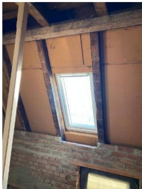
Bilder 23 und 24, Aufsparrendämmung im Mansardbereich
