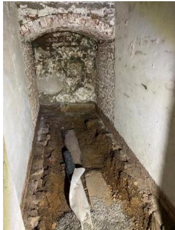
Bild 30, Mit der Erneuerung der Grundleitungen wurde begonnen.
