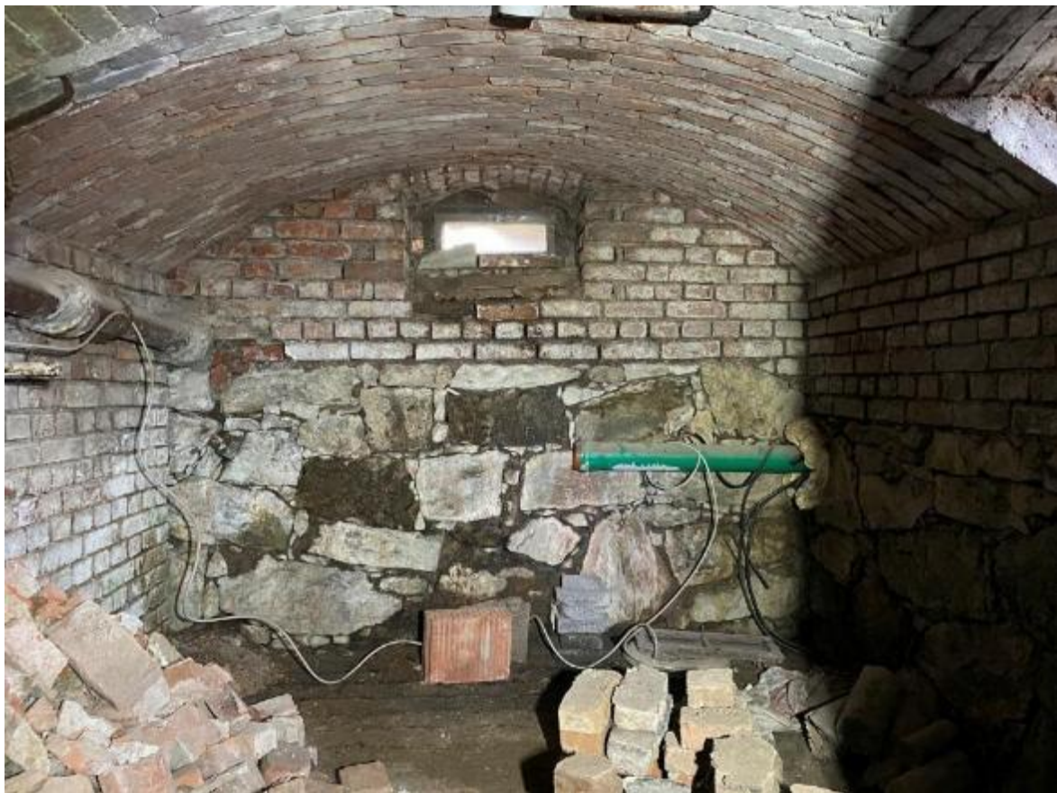
Bild 31, Der Kellerfußboden wurde aufgenommen und z. T. wurde bereits Schüttung eingebracht.
