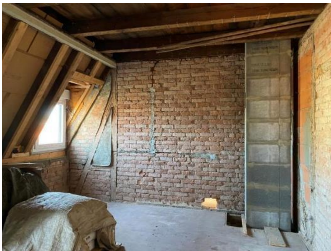
Bild 20, neu errichteter Schornstein
