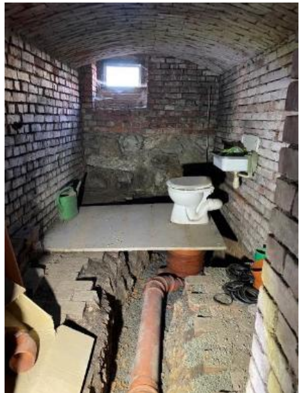
Bild 35, erneuerte Grundleitung
