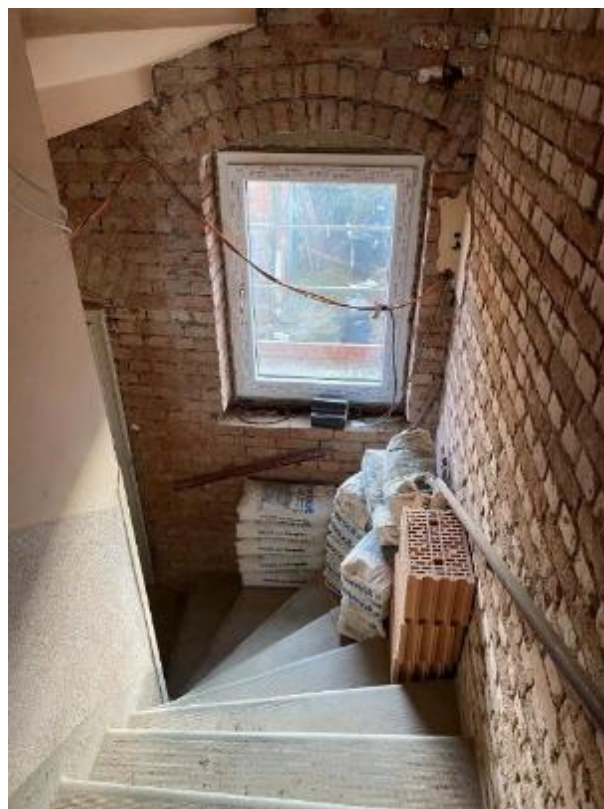
Bild 13, Treppe zum Obergeschoss
