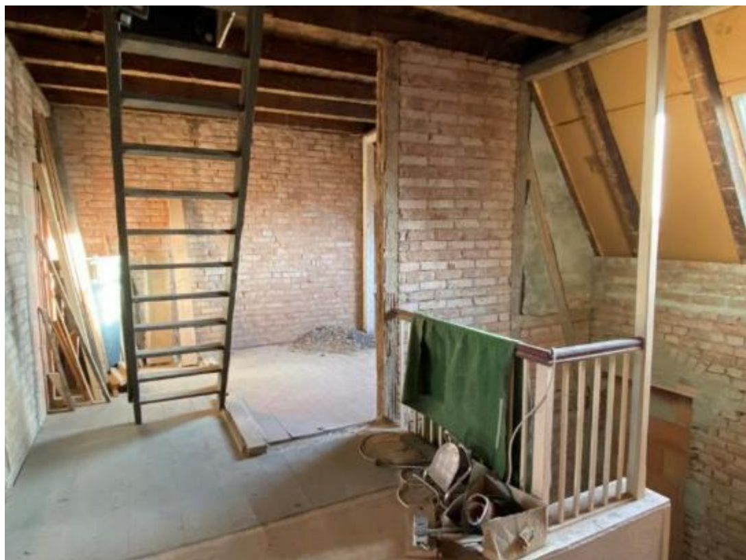
Bild 22, Treppenhaus und Treppe zum Dachboden
