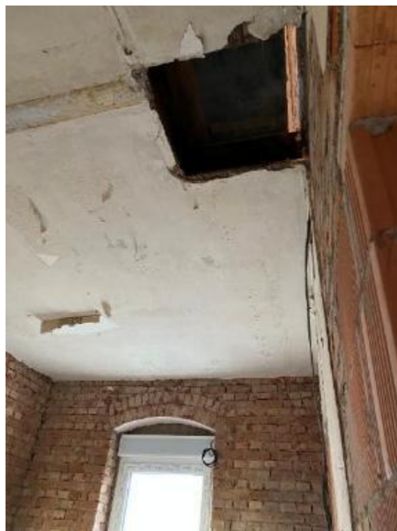
Bild 10, abgebrochener Schornstein
