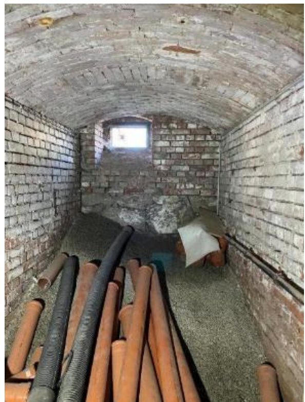
Bild 33, Raum mit bereits eingebrachter Schüttung
