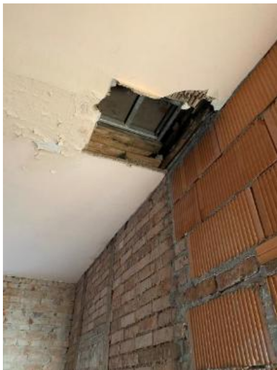
Bild 17, abgebrochener Schornstein
