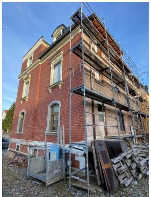
Bild 6, Giebelansicht und Rückseite von Süden
