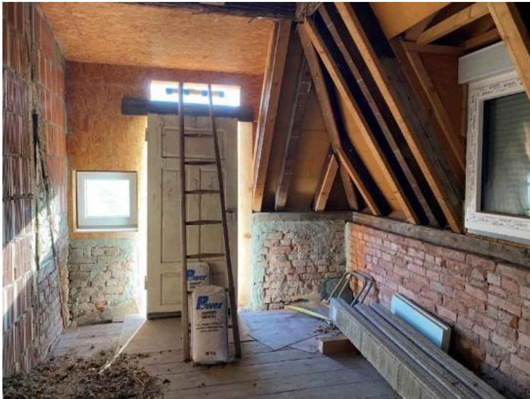
Bild 21, neu errichtete Gaupe hofseitig
