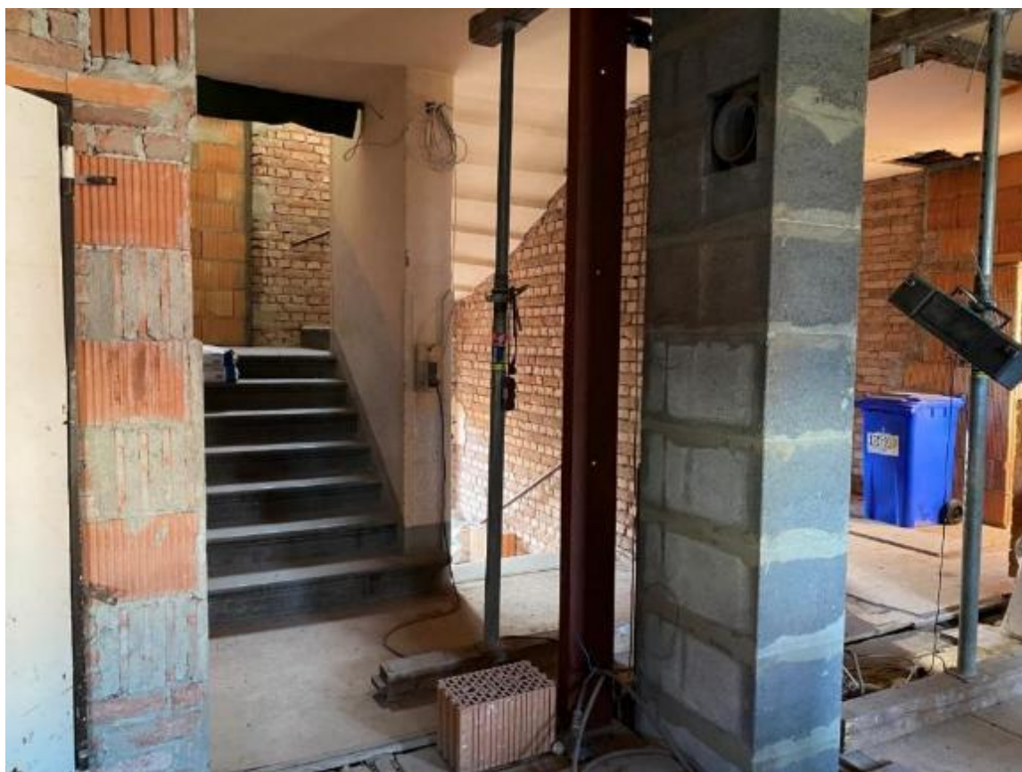
Bild 16, neu errichteter Schornstein
