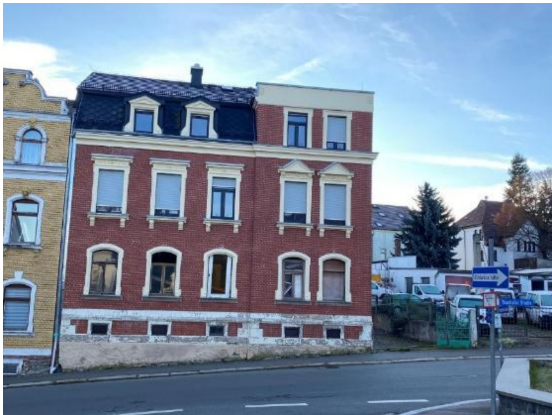
Bild 4, Ansicht von der Thanhofer Straße
