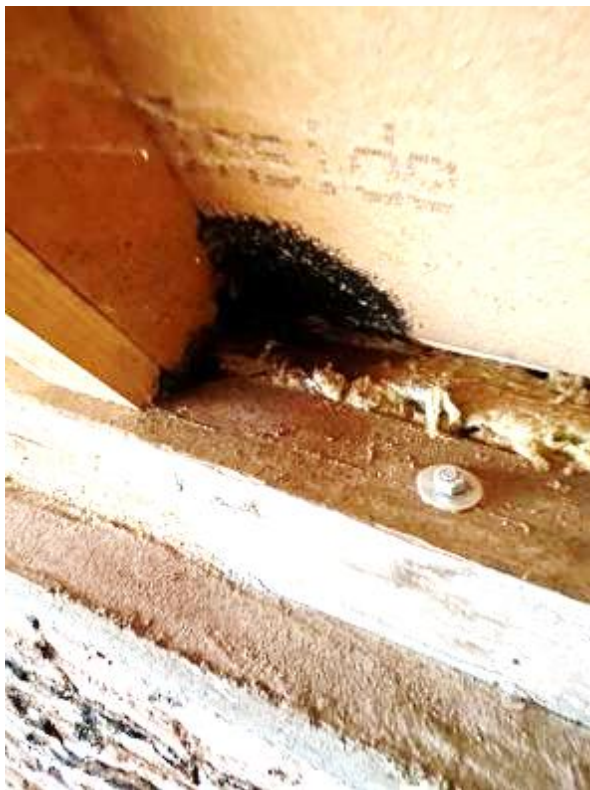
Bild 25, Feuchtigkeitsschaden im Mansardbereich straßenseitig
