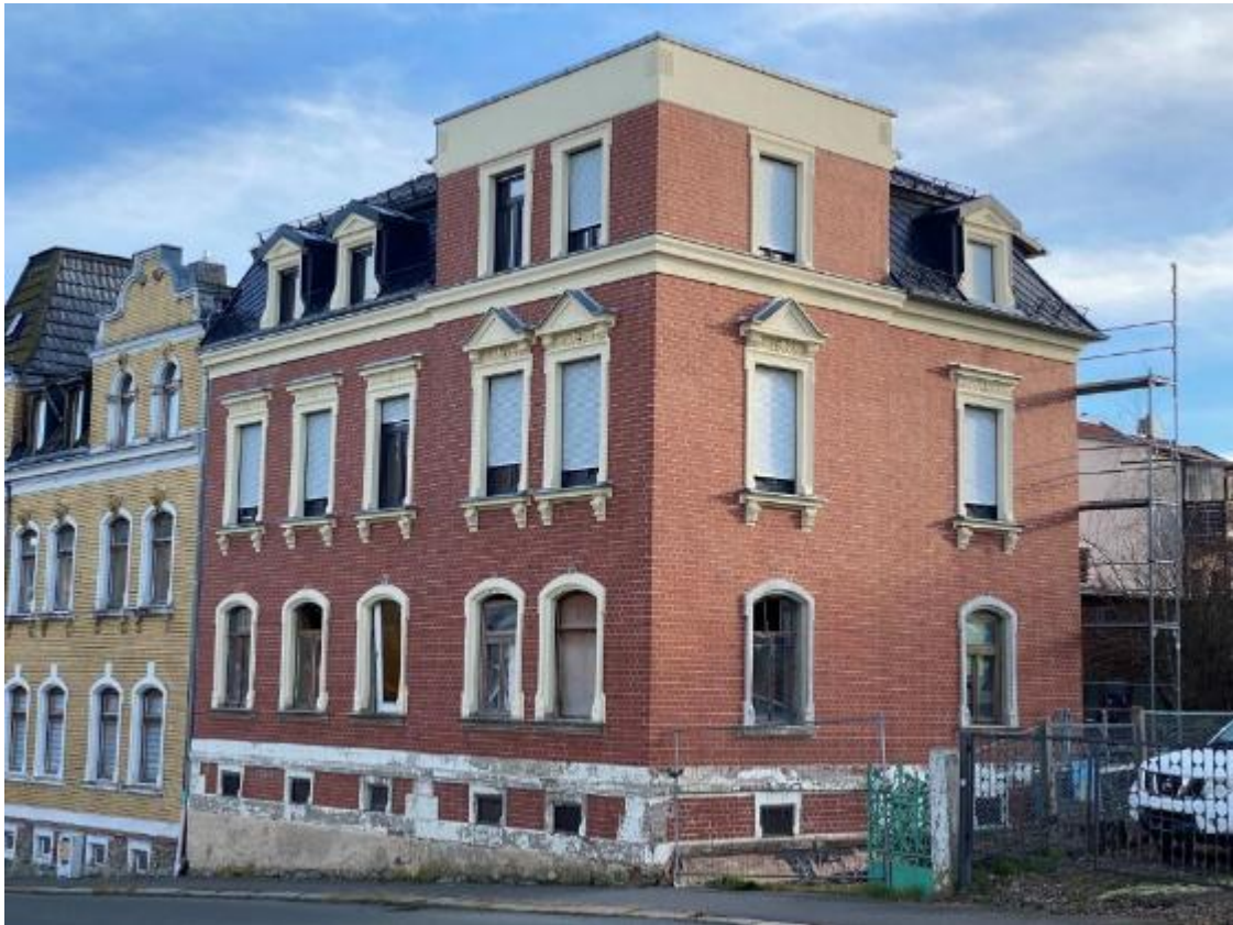
Bild 3, Ansicht der Straßen- und Giebelseite des Gebäudes Thanhofer Straße 18 von Westen
