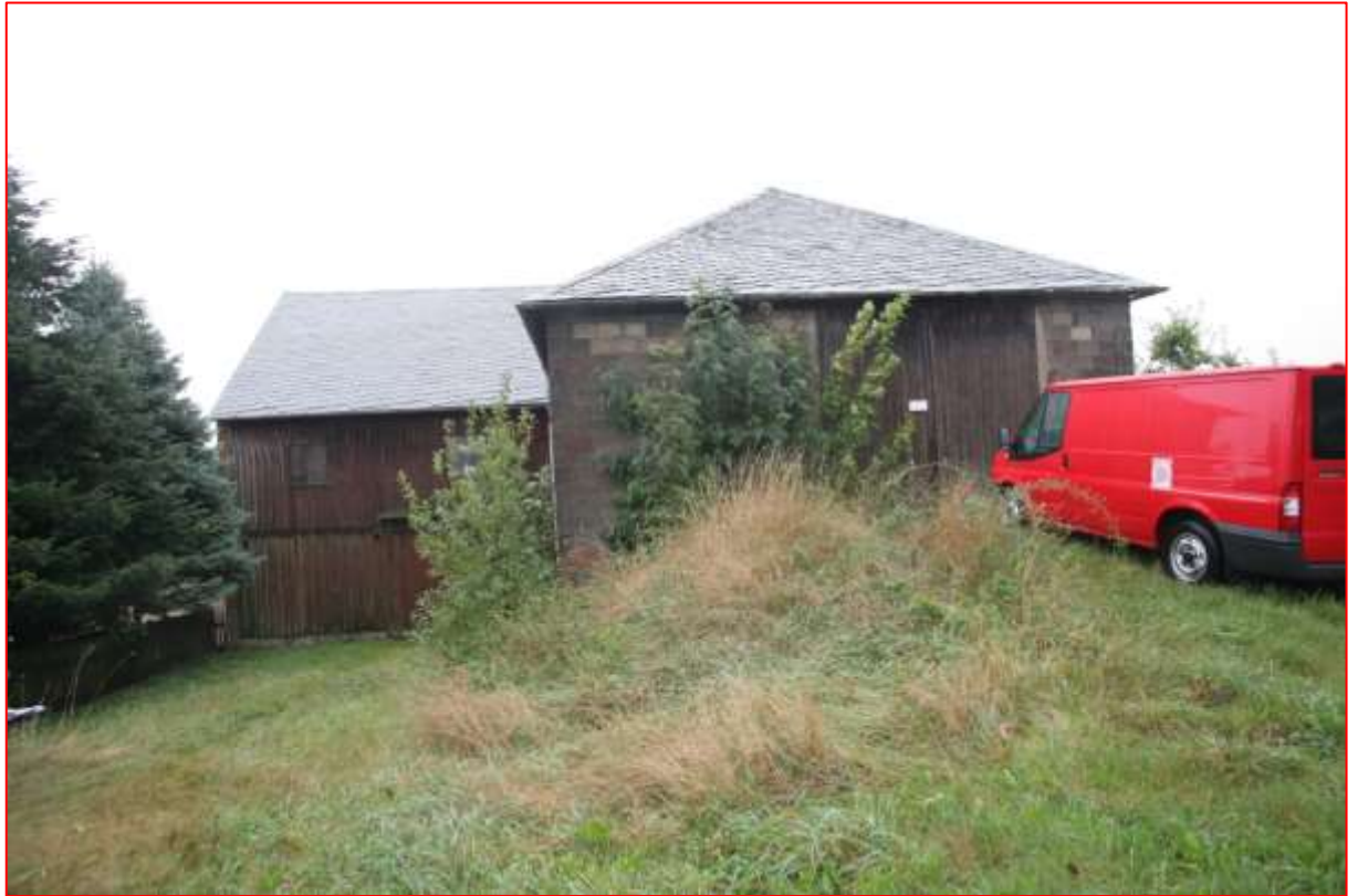
Bild 5 Scheune mit Anbau, Ansicht von Nord
