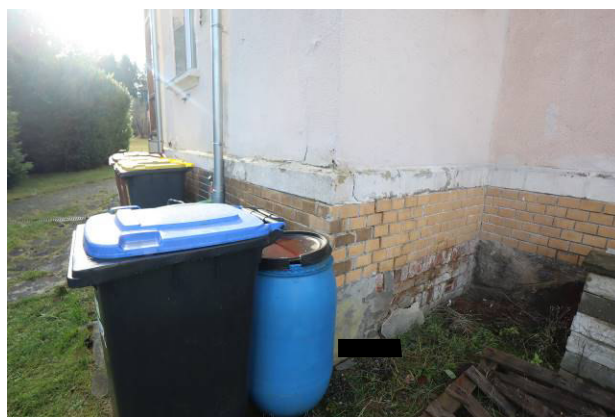
Detailansicht der Feuchtigkeitsschäden im Sockelbereich (hofseitig)
