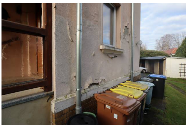
Detailansicht der Putzschäden (hofseitig)
