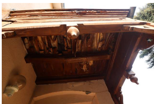
Detailansicht des baufälligen Balkons
