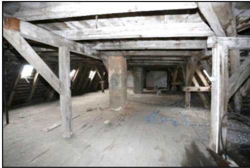
Blick in den nicht ausgebauten Dachboden
