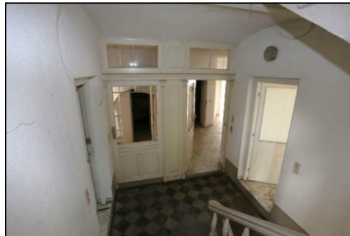
Blick in das Treppenhaus in einem Obergeschoss
