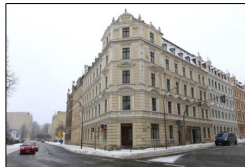
Blick auf das Eck-Wohn- und Geschäftshaus
