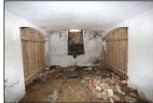
Blick in den Kellerraum der Bewertungswohnung
