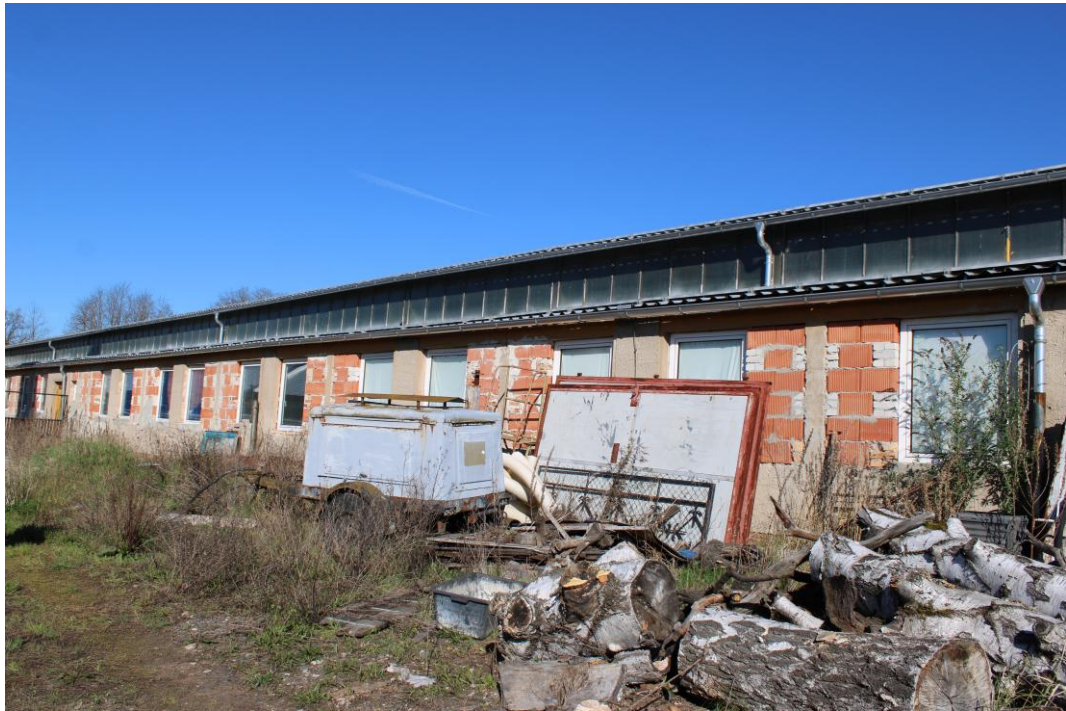
Foto Nr. 3: Überbauter Grundstücksbereich bei Flurstück 509/2
