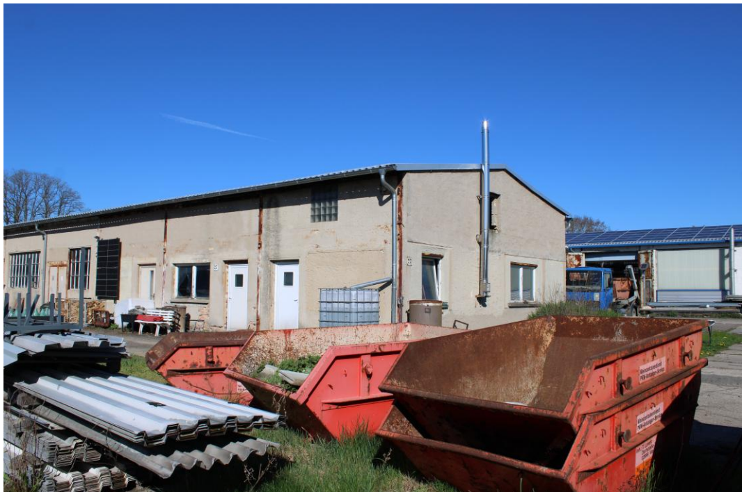
Foto Nr. 4: Überbauter Grundstücksbereich bei Flurstück 509/1
