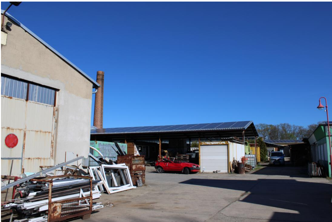
Foto Nr. 2: Überbauter Grundstücksbereich bei Flurstück 509/3
