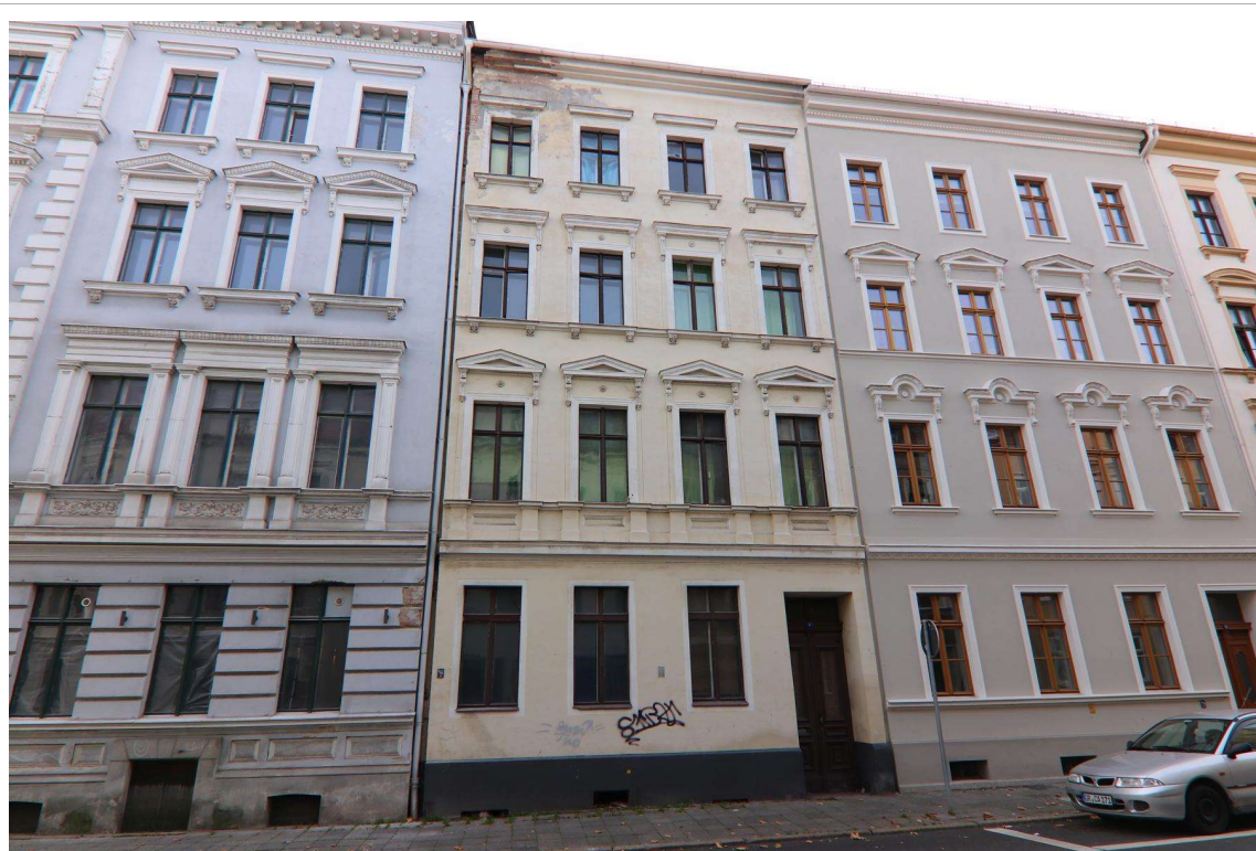
Blick in südöstliche Richtung auf das zu bewertende Mehrfamilienhaus Krölstraße 1.
