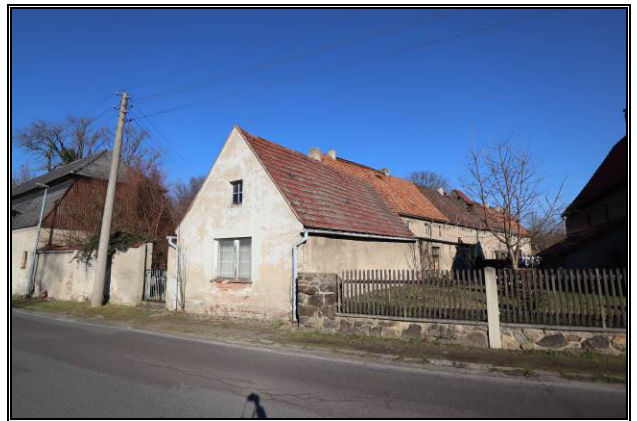
Süd-Ansicht des Nebengebäudes
