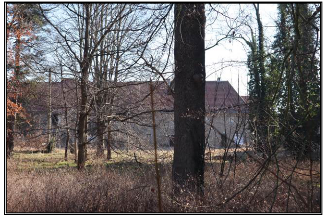
Nord-West-Ansicht des ehem. Wirtschaftsgebäudes inkl. Gutspark
