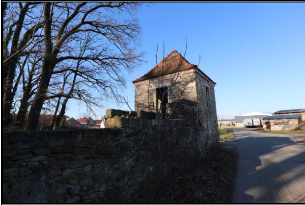
Ost-Ansicht des denkmalgeschützten Pavillon
