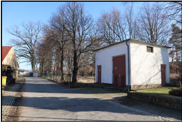
West-Ansicht der Trafostation
