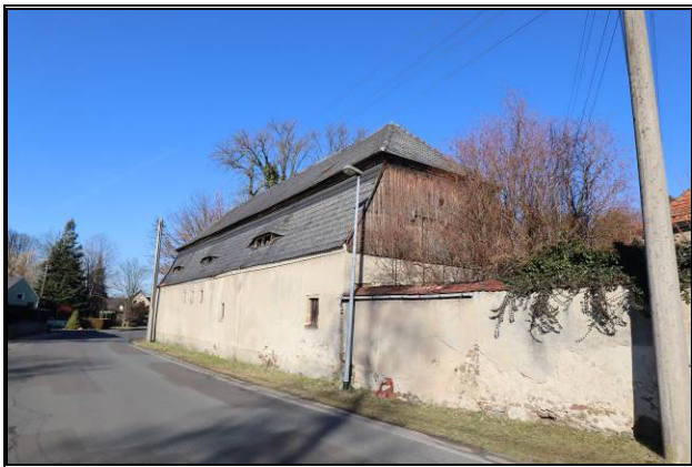
Süd-Ost-Ansicht der Scheune
