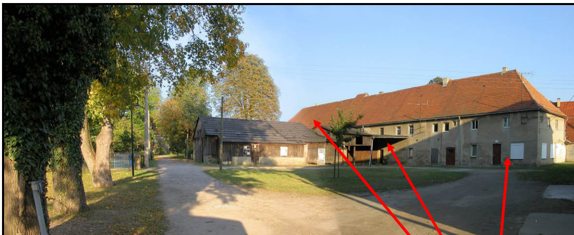
West-Ansicht des Wirtschaftsgebäudes (Quelle: Internet); Nr. 41, 39 und 37
