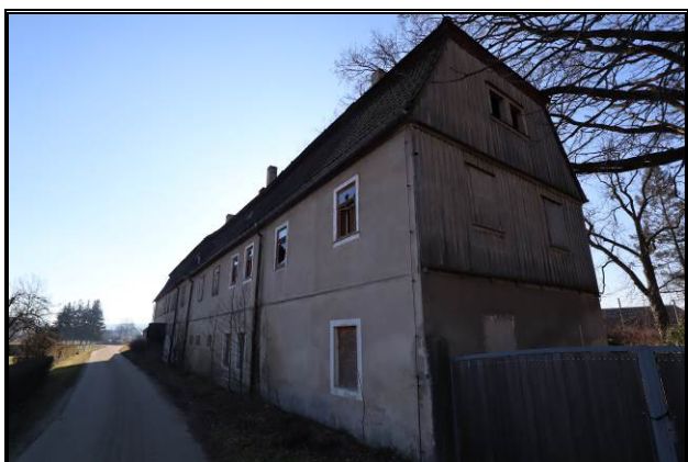
Nord-Ansicht des ehem. Herrenhauses
