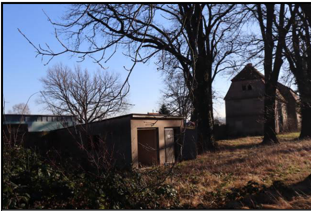
Garage und ehem. Herrenhaus (West-Ansicht)
