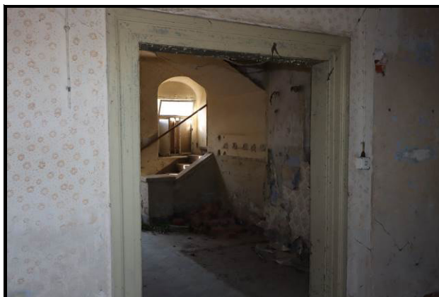
Teil der Innenansicht des ehem. Herrenhauses – Blick durch das Fenster
