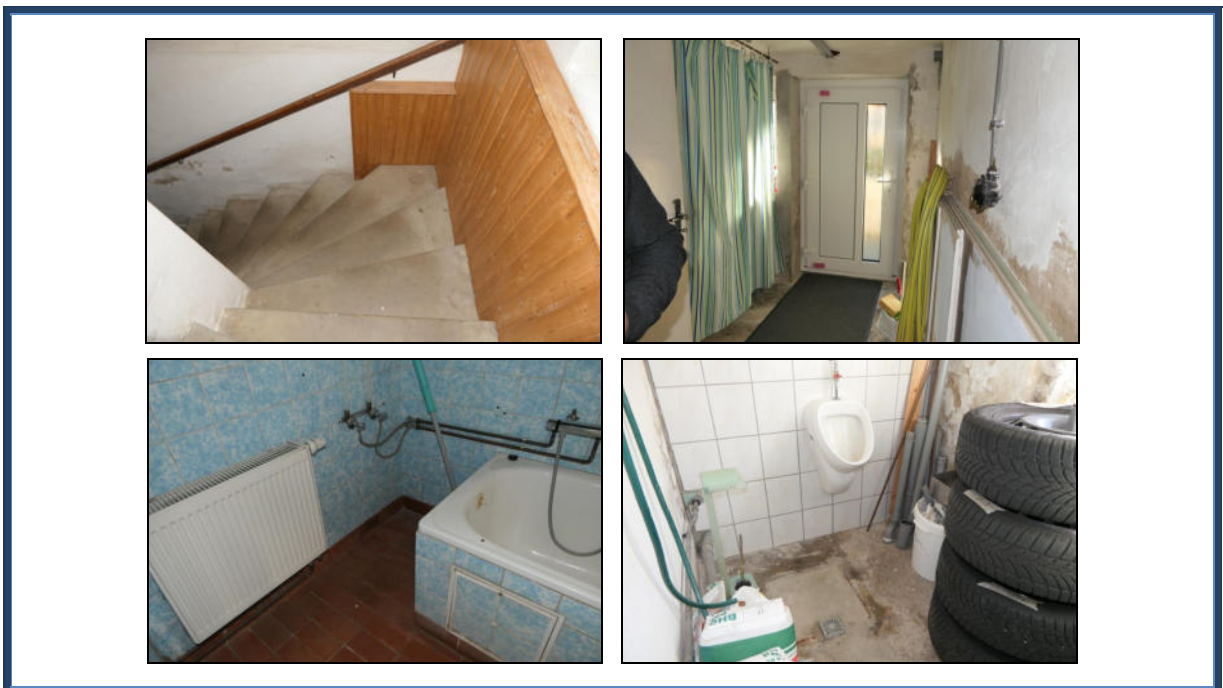
Abbildung 8: Kellerzugang; einfache Sanitäranlagen im Kellergeschoss
