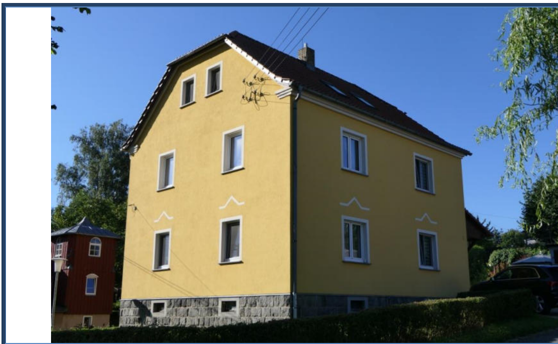
Abbildung 1: Nord-Ost-Ansicht; Außenanlagen; umliegende Bebauung
