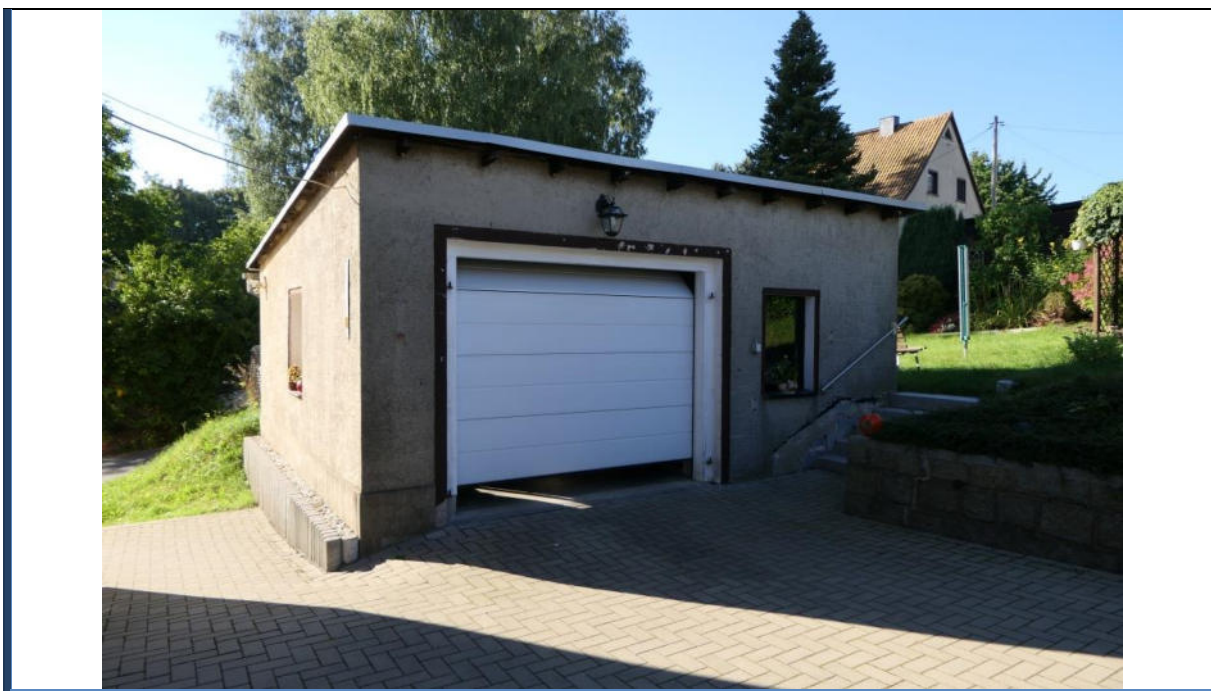
Abbildung 31: Garage I; Außenanlagen; umliegende Bebauung
