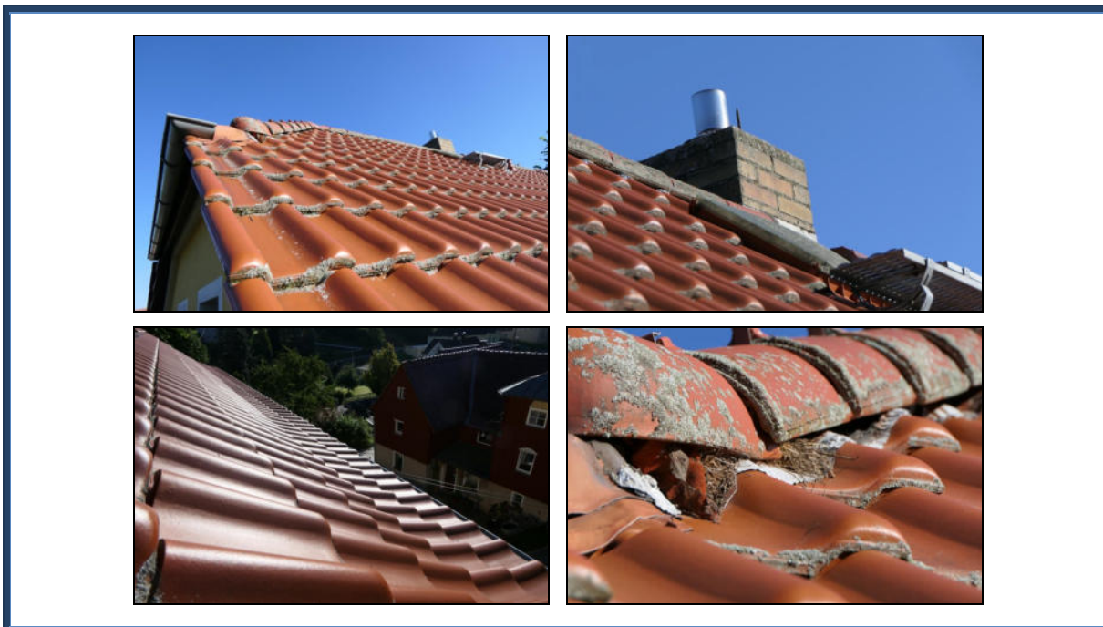
Abbildung 30: Detailansichten der Dacheindeckung
