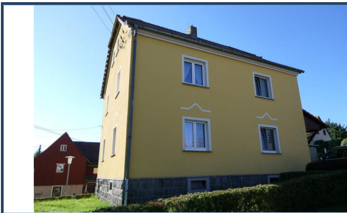
Abbildung 2: Nord-Ansicht; Außenanlagen; umliegende Bebauung
