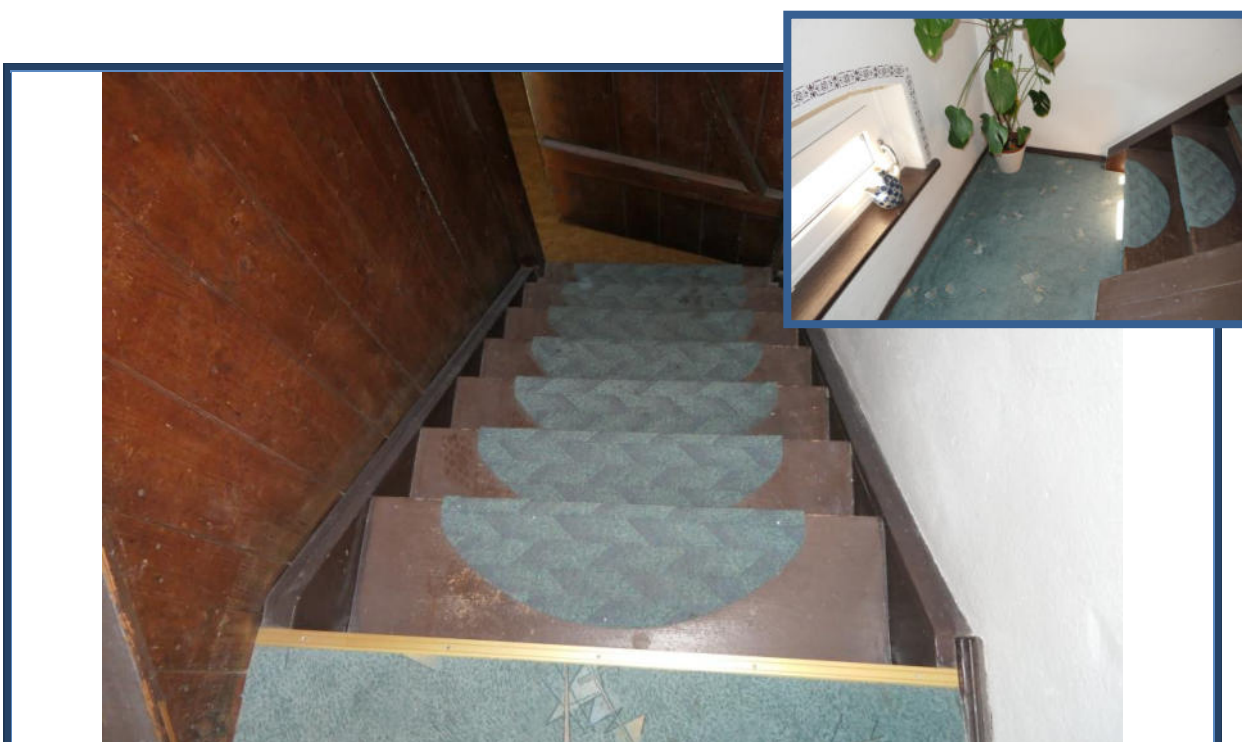
Abbildung 20: Einfache Holztreppe zwischen Ober- und Dachgeschoss
