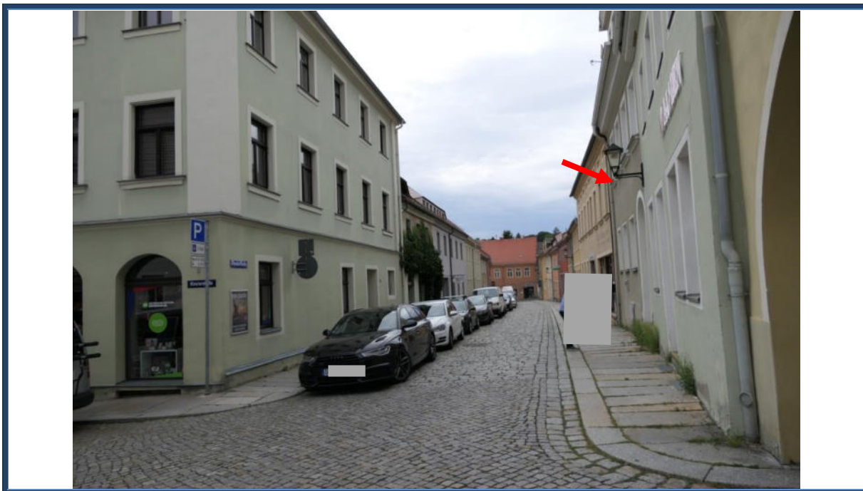
Abbildung 7: Blick in die Theaterstraße in westliche Richtung; Kreuzungsbereich der Theaterstraße und Klosterstraße; rechts das Bewertungsobjekt; umliegende Bebauung
