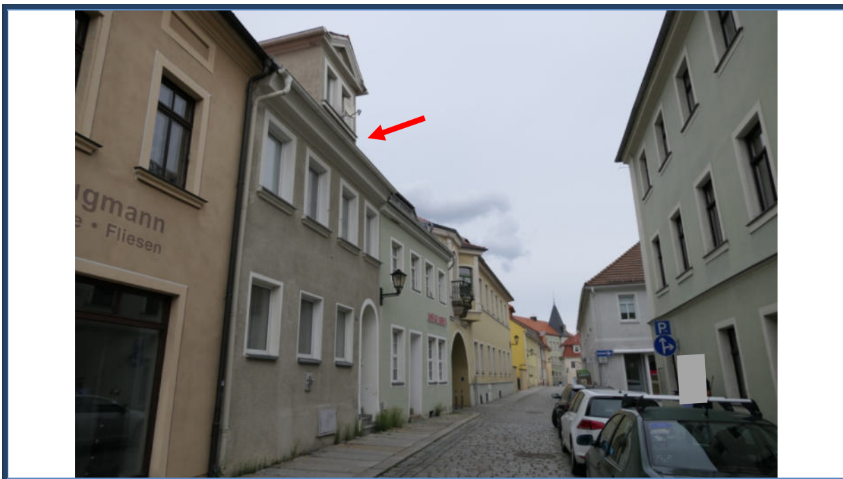
Abbildung 8: Blick in die Theaterstraße in östliche Richtung; links das Bewertungsobjekt; angrenzende und umliegende Bebauung
