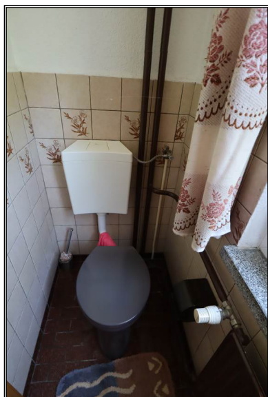
WC im Erdgeschoss
