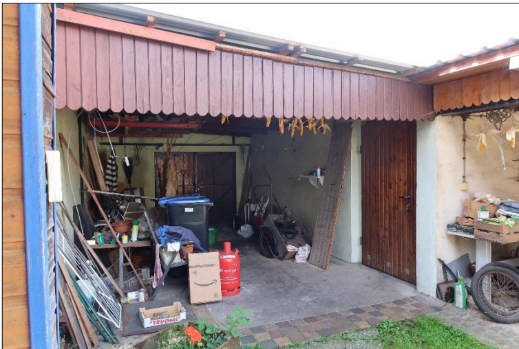
Hofansicht Carport/Wäscheplatz / Zugang zur Einzelgarage
