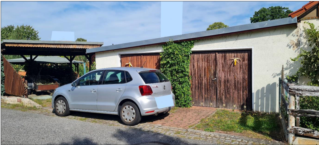
Straßenansicht des Holzcarports (links), Einzelgarage (mitte) und Carport/Wäscheplatz (rechts)
