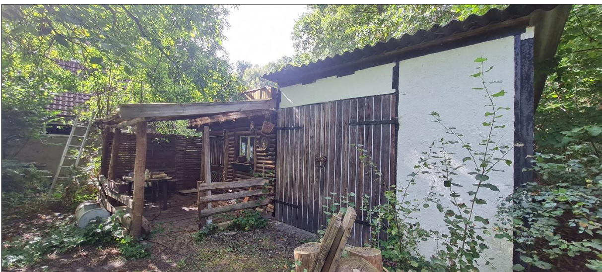
Einzelgarage mit angrenzender Holzhütte
