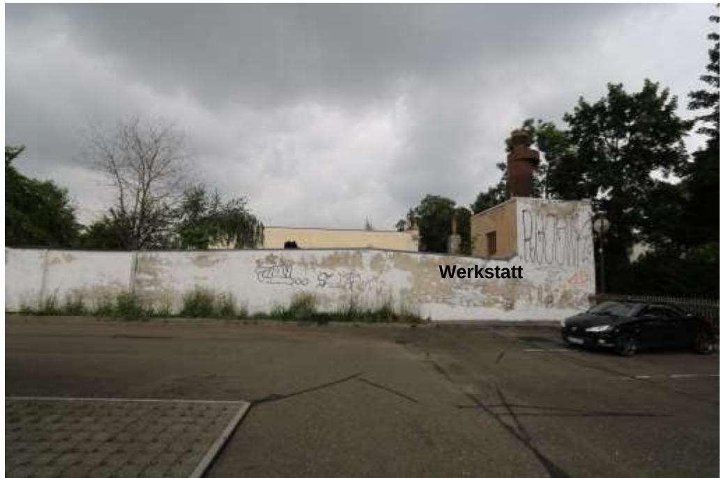
Südansicht (östl. Grundstücksteil)
