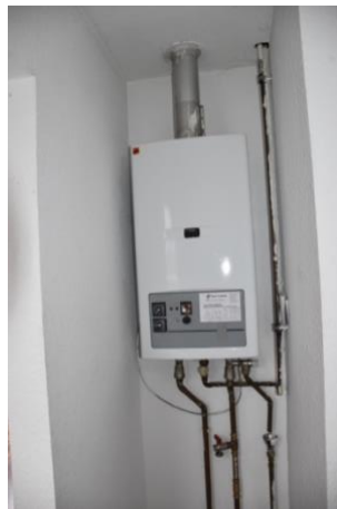
Foto 28: separate Heiztherme
