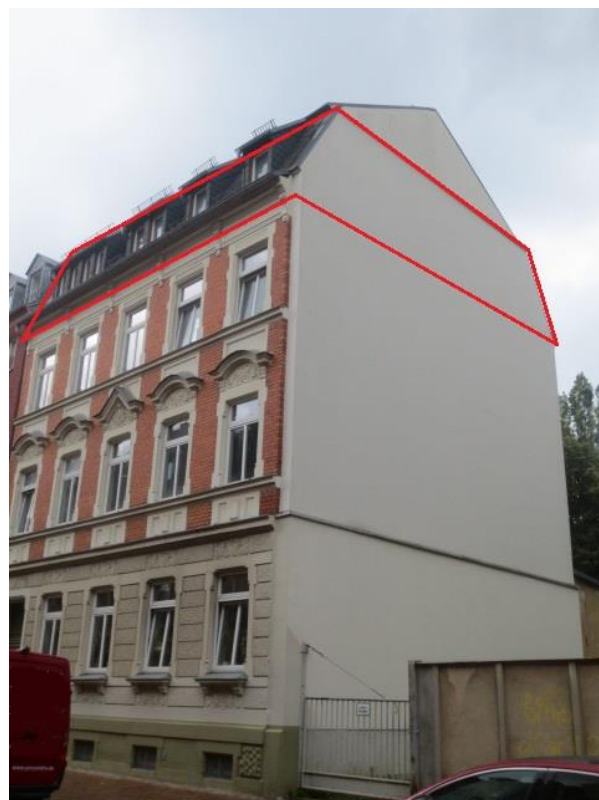
Ostansicht mit geschlossener Giebelseite
