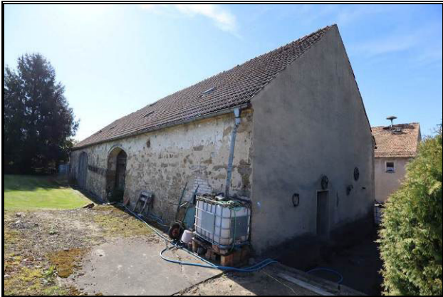
Nord-West-Ansicht der Scheune
