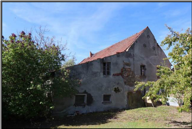
Nord-Ost-Ansicht des Stallgebäudeanbaus (Abbruch)
