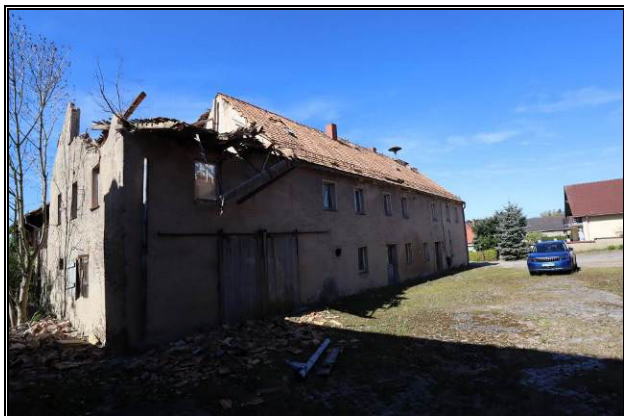
Nord-Ost-Ansicht des Wohnstallhauses mit Anbau (Anbau Abbruch)
