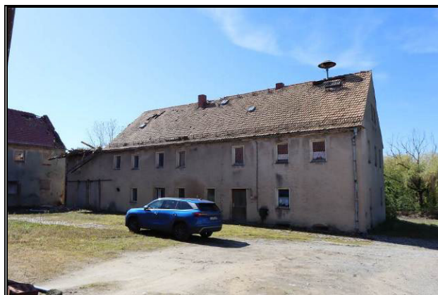
Nord-Ansicht des Wohnstallhauses
