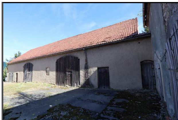
Süd-Ansicht der Scheune
