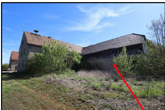
Süd-West-Ansicht des Wohnstallhauses mit Stallanbau (Abbruch)
