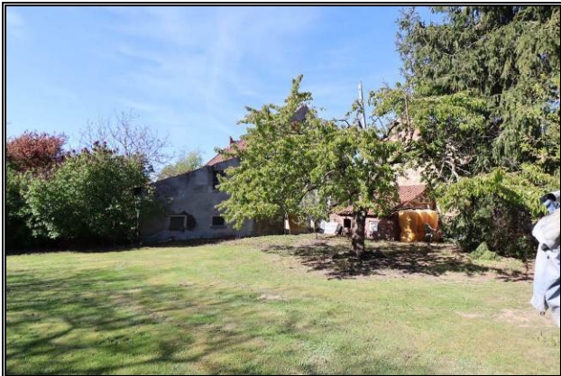
Nord-Ansicht des Teilbereichs A
