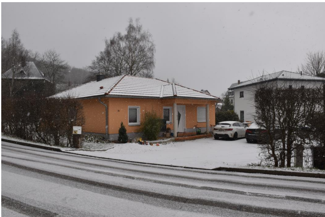
Foto 2: Nordwestansicht von der Ernst – Thälmann – Straße, Grundstückszufahrt
