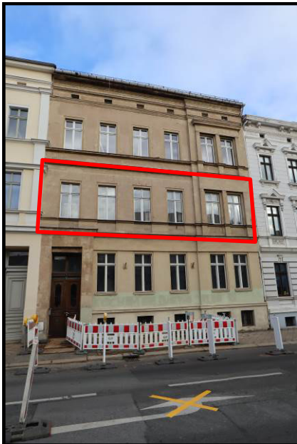
Süd-Ansicht des Mehrfamilienhauses Schützenstraße 5; Bewertungsobjekt
