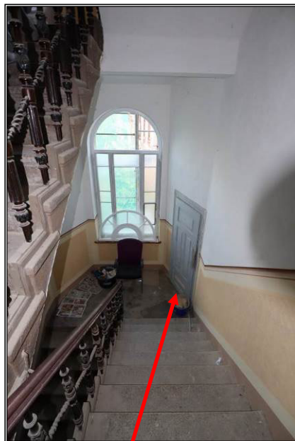
Treppenhaus mit Abstellkammer auf halber Treppe
