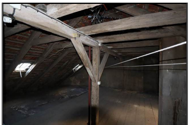
Dachboden (im Sondereigentum)
