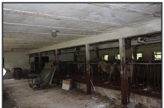
Innenansicht des Stallgebäudes 2 (Blick durch ein Fenster)
