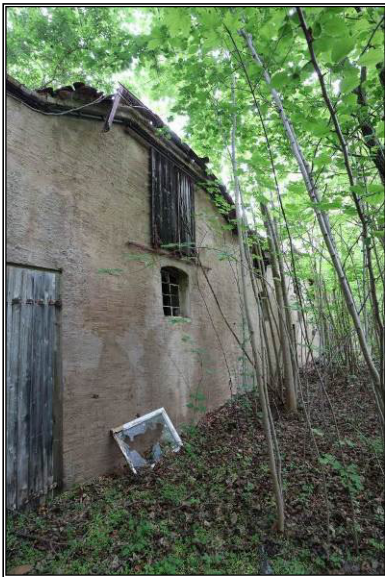
Süd-West-Ansicht des Stallgebäudes 1
