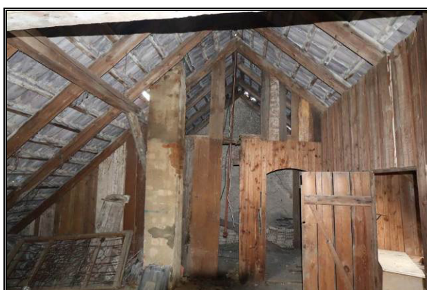
Teil des Dachbodens (Wohnhaus)
