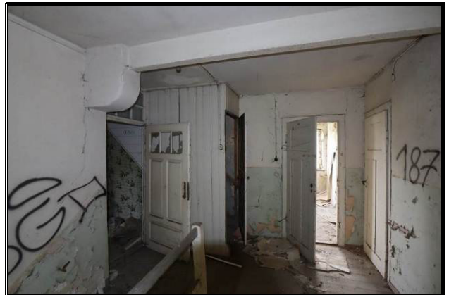
Treppenflur im OG des Wohnhauses
