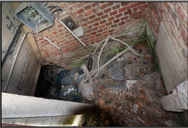
Blick zum Kellerzugang der Scheune
