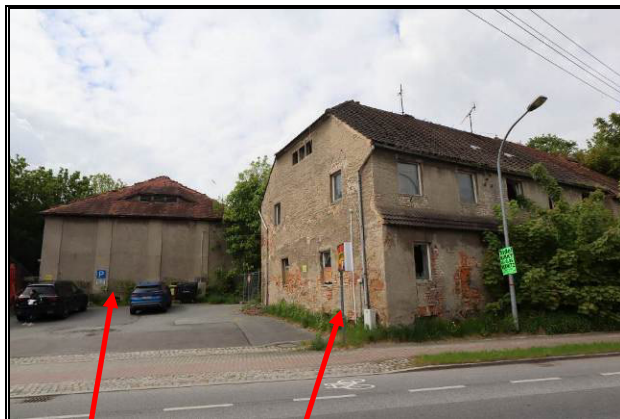
Scheune und ehem. Wohnhaus (Nord-Ost-Ansicht)
