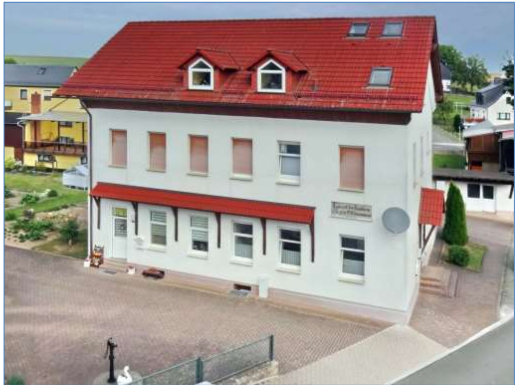
Bild 1 Eigentumswohnanlage, Straßenansicht als Hochbild
