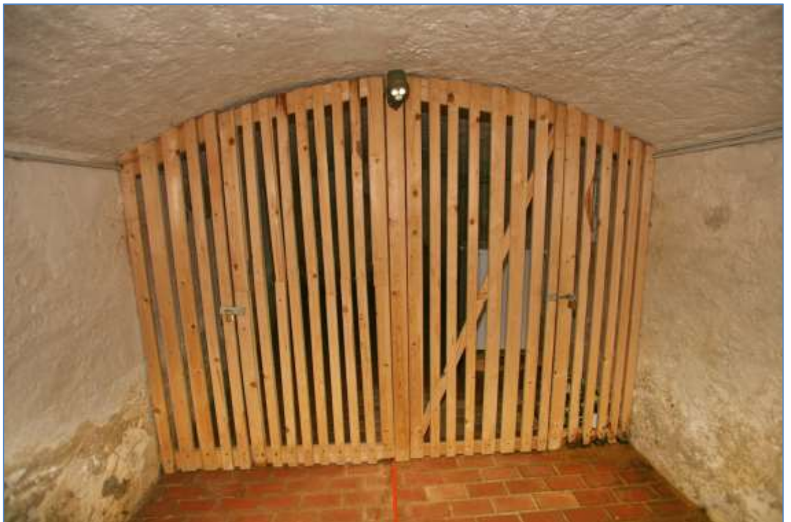
Bild 8 Kellergeschoss, Keller der Wohnung (römisch) 1 (rechts) und 2 (links)
