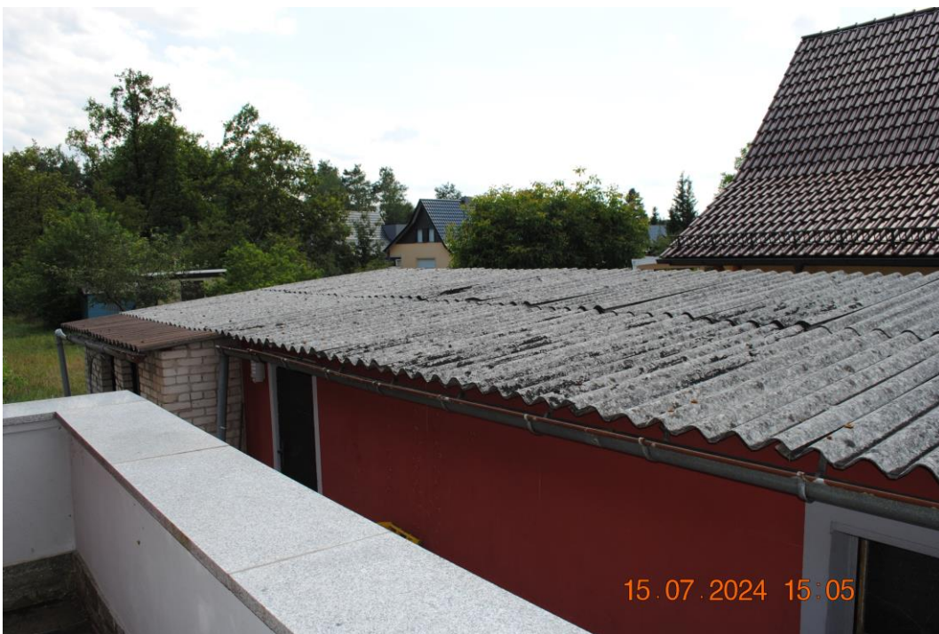
Foto Nr. 5: Blick auf das Garagendach mit Schuppenanbau im Gartenbereich
