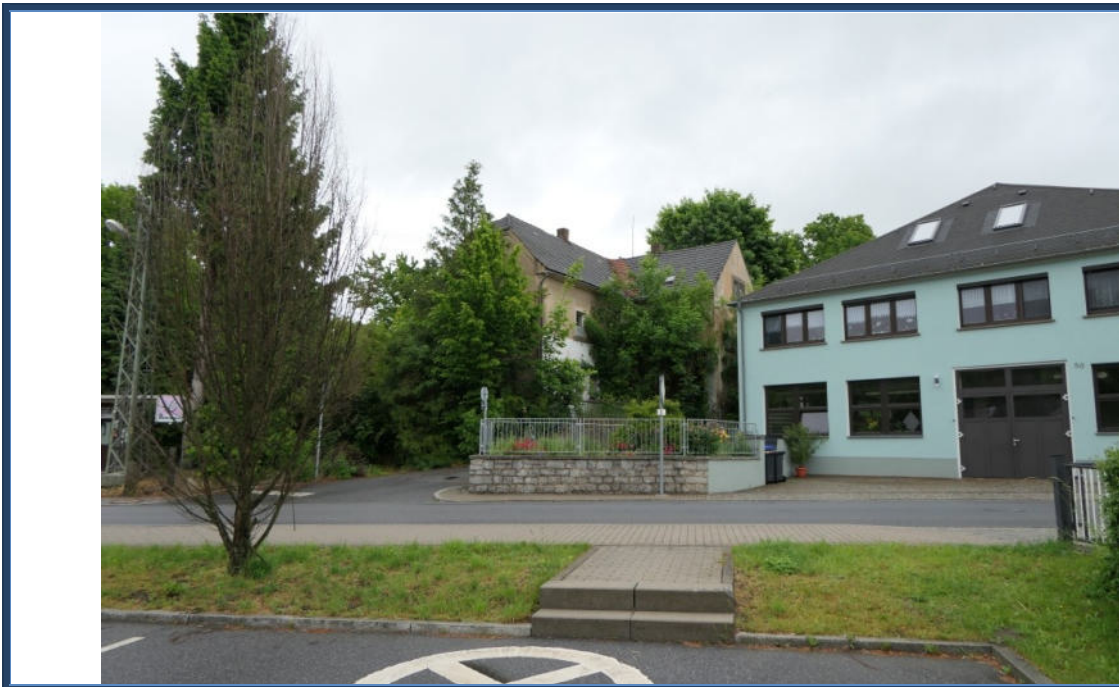
Abbildung 23: Blick in nordöstliche Richtung vom gegenüberliegenden Parkplatz zum Bewertungsobjekt; Einfahrtsbereich zur Straße "Am Sportplatz"; umliegende Bebauung
