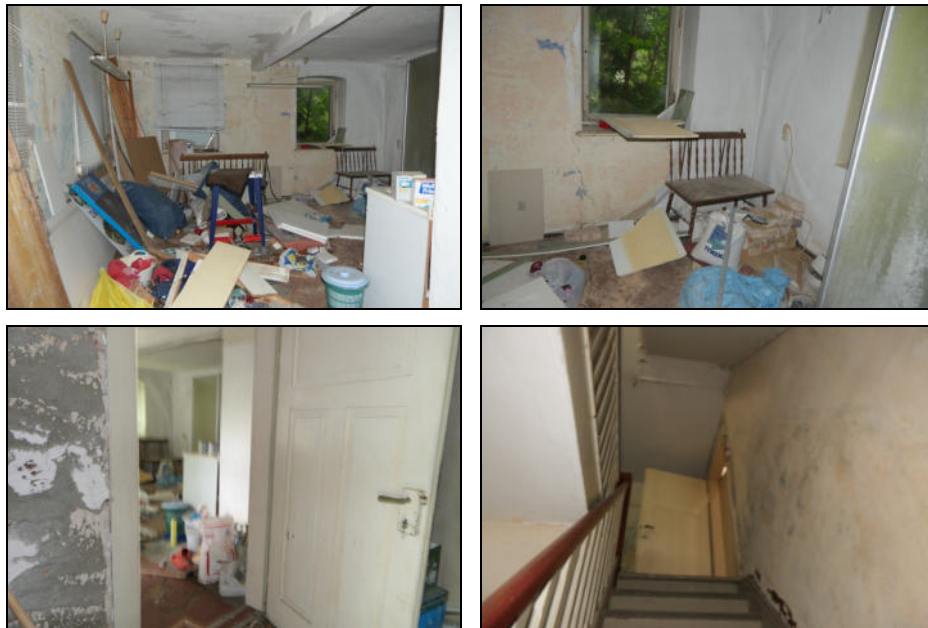
Abbildung 7: Räume im Erdgeschoss des Hauptgebäudes; Treppe zum Obergeschoss
