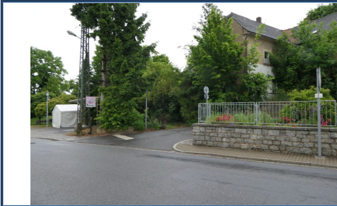
Abbildung 21: Blick in nordöstliche Richtung von der Pulsnitztalstraße zum Bewertungsobjekt; Einfahrtbereich zur Straße "Am Sportplatz"; stark verwilderte und beschädigte Außenanlagen
