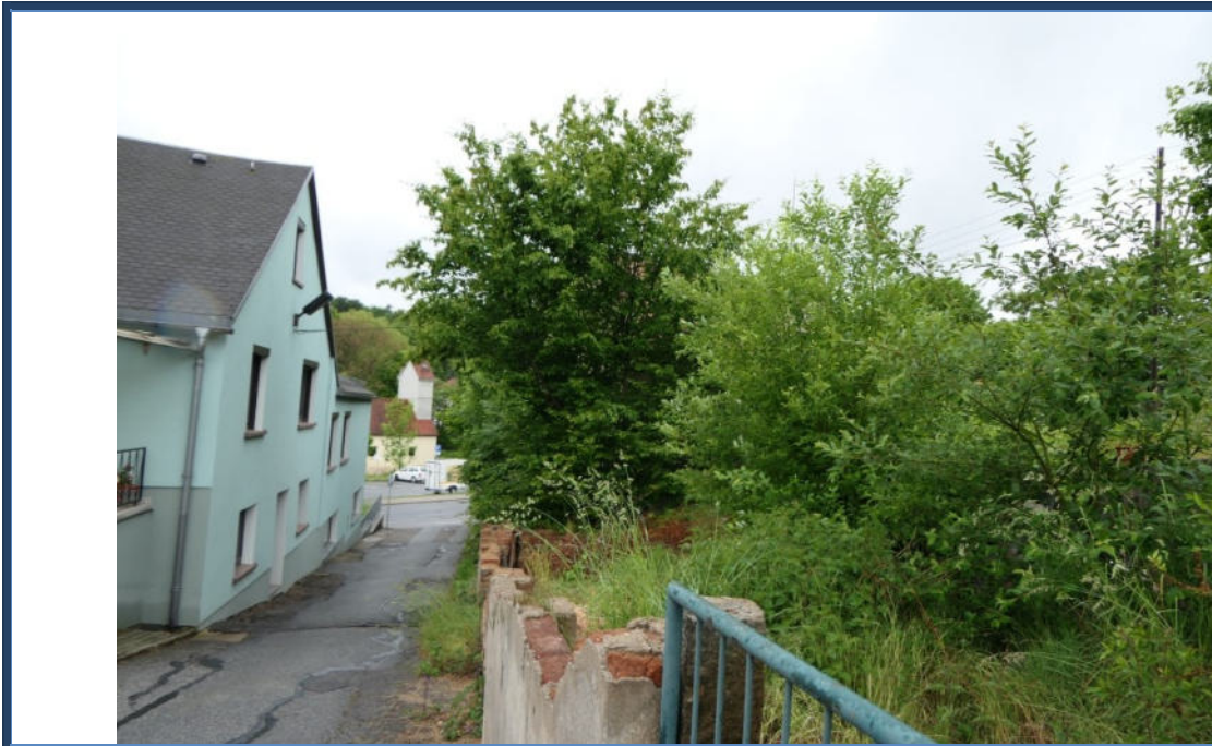
Abbildung 19: Blick in westliche Richtung in die Straße "Am Sportplatz"; rechts das Bewertungsobjekt stark verwilderte und beschädigte Außenanlagen; umliegende Bebauung
