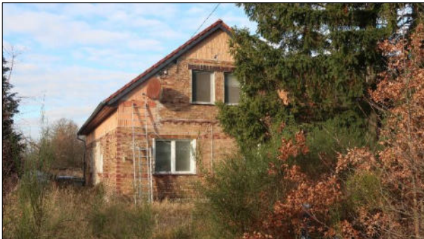
Straßenansicht des Wohnhauses von der Dorfstraße
