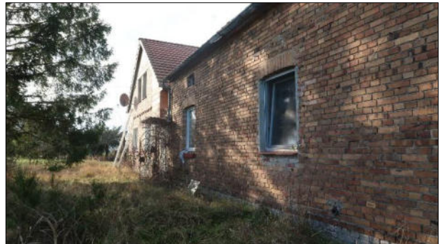
Vorderer Wohnungszugang zwischen Wohnhaus und Nebengebäude
