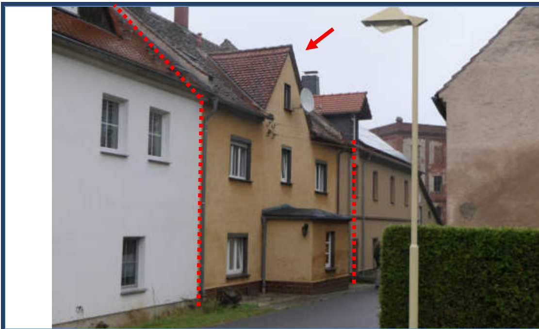
Abbildung 2: Straßenansicht (Süd-Ansicht); Eingangsbereich; angrenzende Bebauung; rechts das Mehrzweckgebäude auf Flurstück 148
