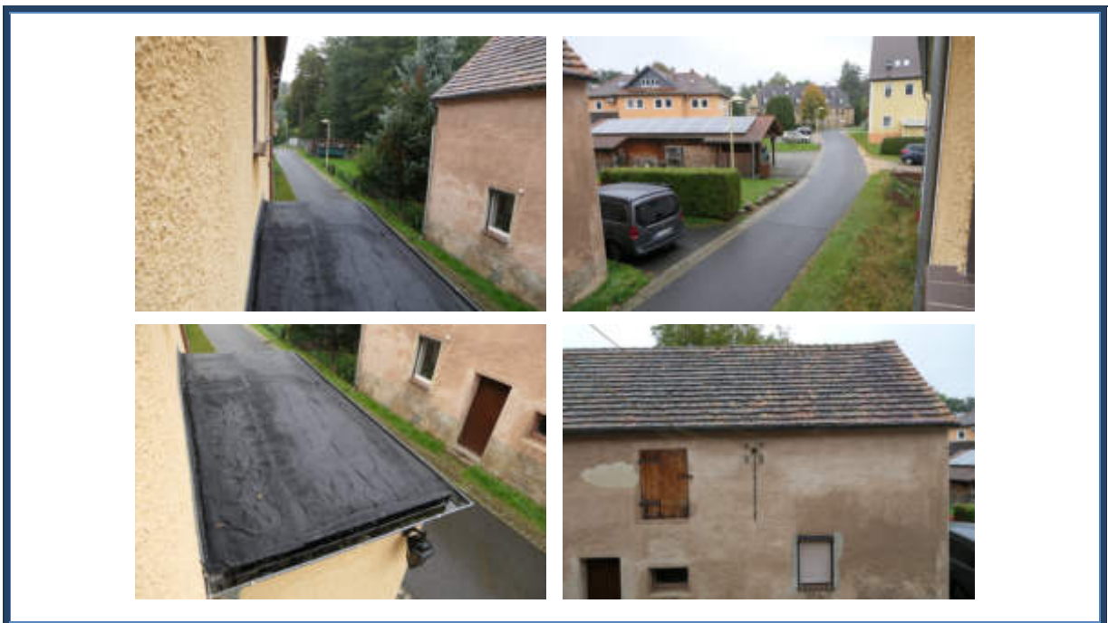
Abbildung 8: Blick aus dem Obergeschoss in nördliche Richtung; gegenüber das Mehrzweckgebäude auf Flurstück 148; umliegende Bebauung
