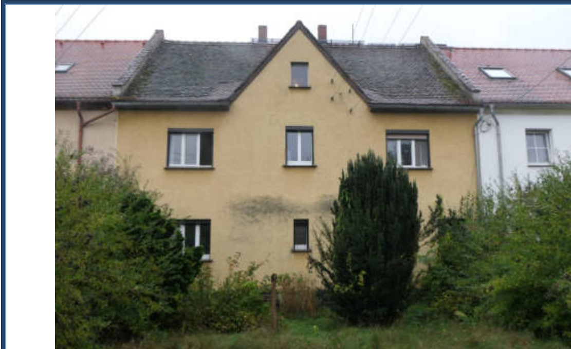
Abbildung 1: Gartenansicht (Nord-Ansicht); verwilderte Außenanlagen; angrenzende Bebauung
