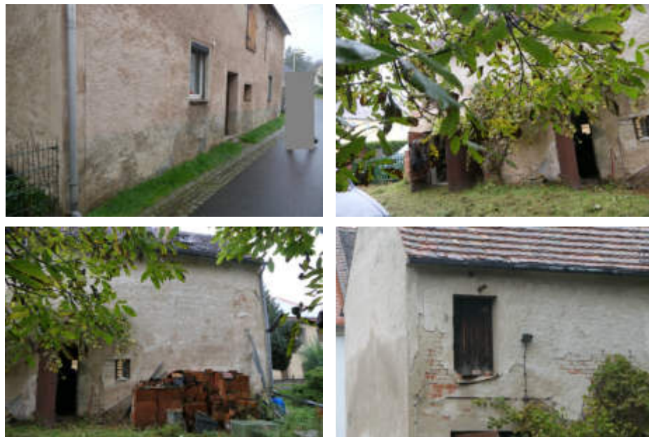
Abbildung 10: Mehrzweckgebäude auf Flurstück 148
