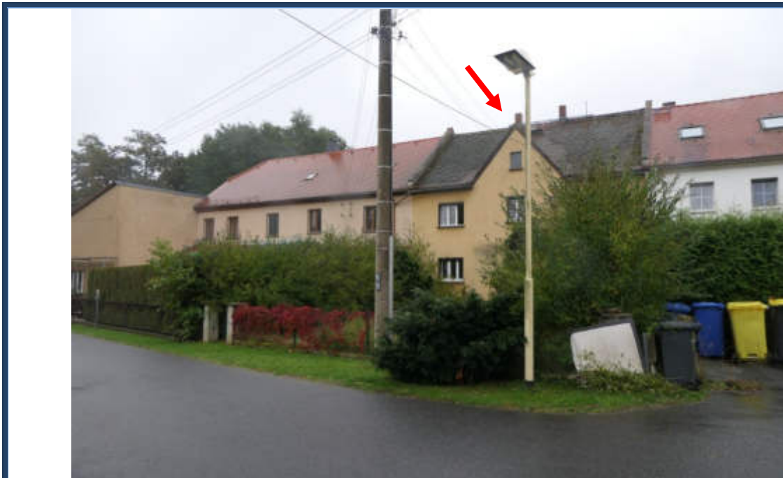
Abbildung 19: Blick in südöstliche Richtung von der Bergstraße zum Wohngebäude auf Flurstück 140; angrenzende und umliegende Bebauung
