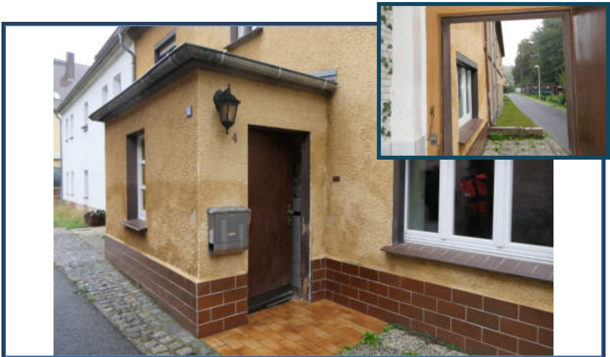
Abbildung 4: Eingangsanbau an der Gebäudesüdseite; angrenzende Bebauung
