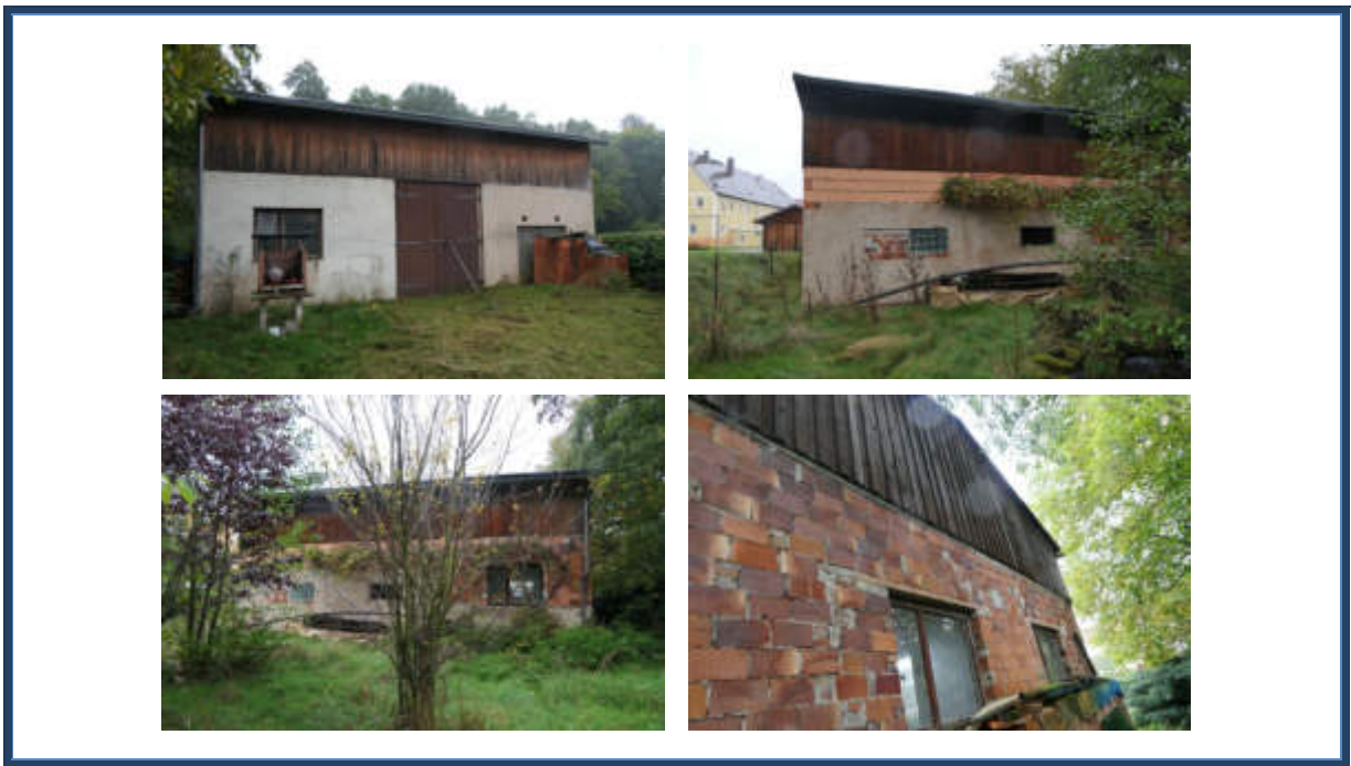
Abbildung 13: Mehrzweckgebäude (Scheune) auf Flurstück 148; verwilderte Außenanlagen
