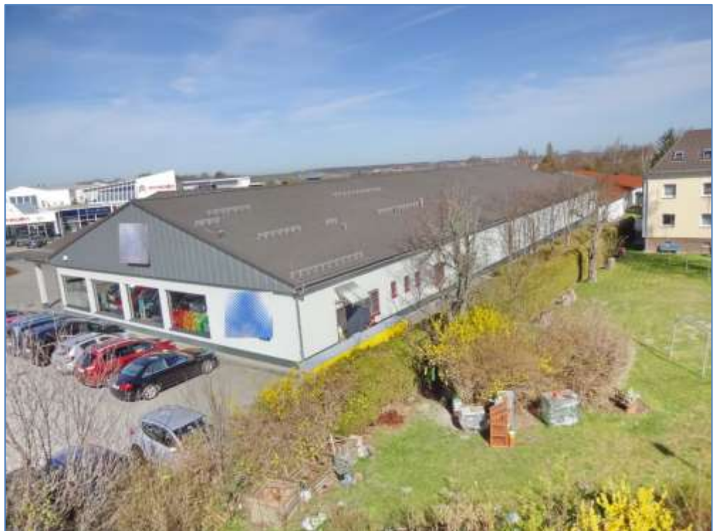
Bild 2 Ansicht von der Lengenfelder Straße von Südost
