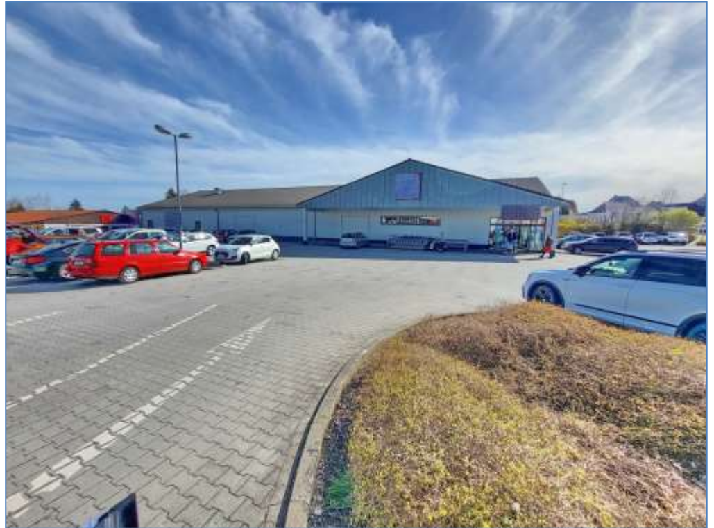
Bild 3 Ansicht von der Straße Am Kreuzberg
