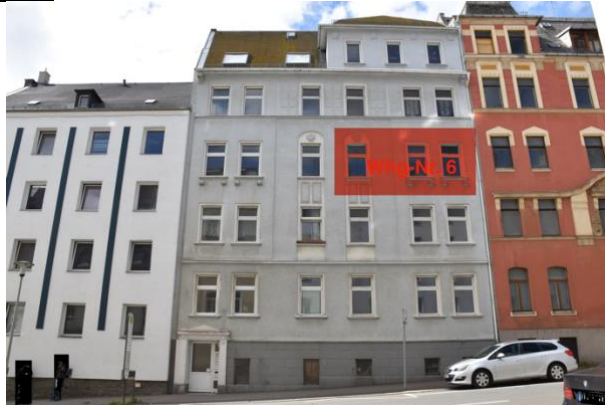
Foto 1: Ostansicht des Gebäudes mit Markierung der Wohnungslage
