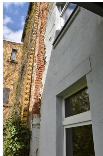
Foto 14: angebautes, leerstehendes Nachbargebäude
