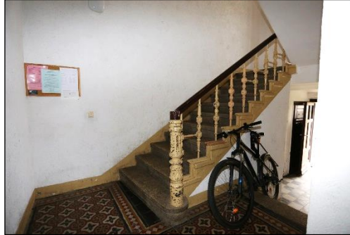
Blick in das Erdgeschoss des Treppenhauses mit Zugang in den Hinterhof sowie den Keller.
