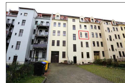
Blick auf die hofseitig ausgerichtete Fassade.
