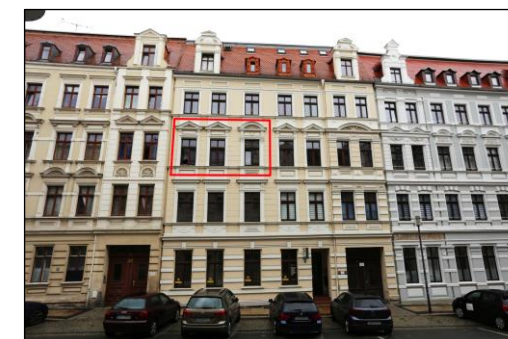
Blick auf die Straßenfassade des Wohn- und Geschäftshauses mit Markierung der Wohnung.
