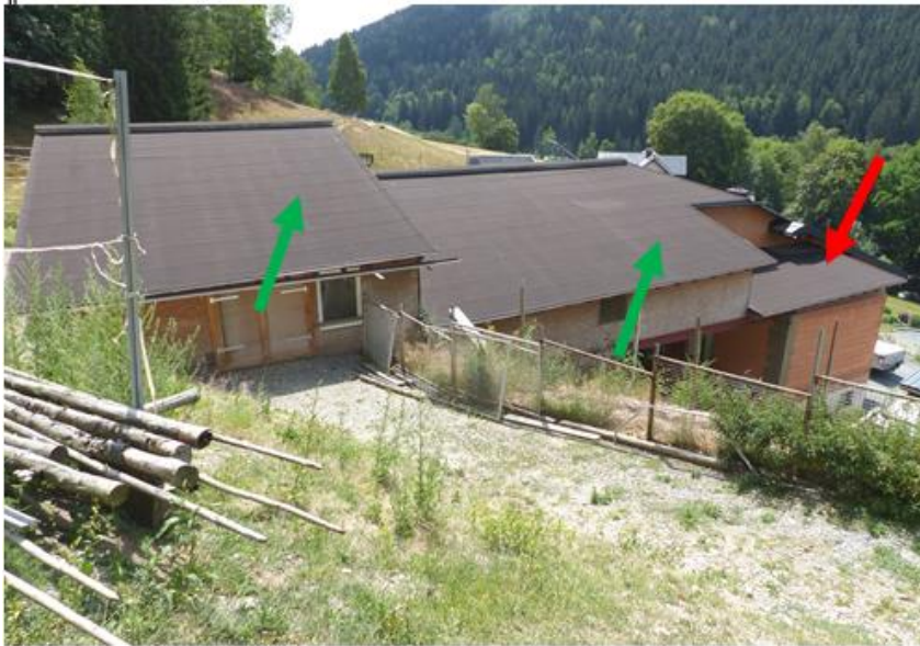
¶ ¶ Nord-West-Ansicht vom Flurstück ¶ ¶ Nr. 866 zum Flurstück Nr. 867 mit neu- ¶ gebautem Wohnhaus (rot) und ¶ angebautem Stall-/Scheunengebäude ¶ (grün) ¶ ¶
