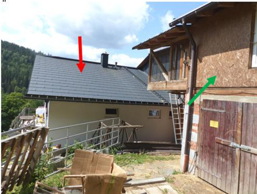
¶ ¶ Nord-Ost-Ansicht zum neu gebauten ¶ Wohnhaus (rot) und angebautem ¶ Stall-/Scheunengebäude (grün) ¶ ¶
