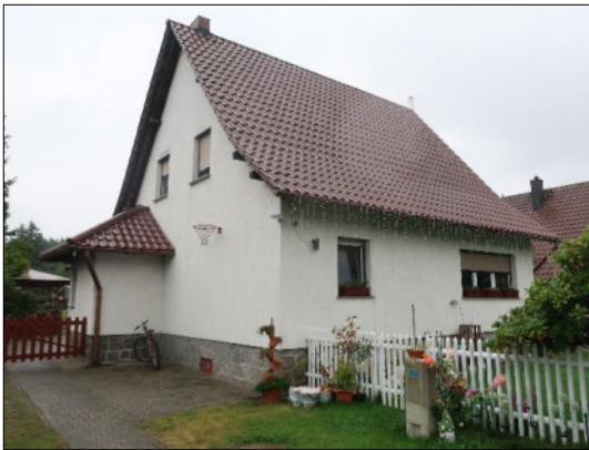
Vorderansicht des Einfamilienhauses
