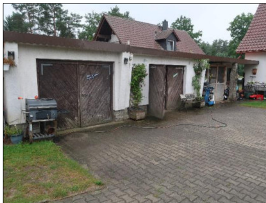
Hofansicht des Nebengebäudes
