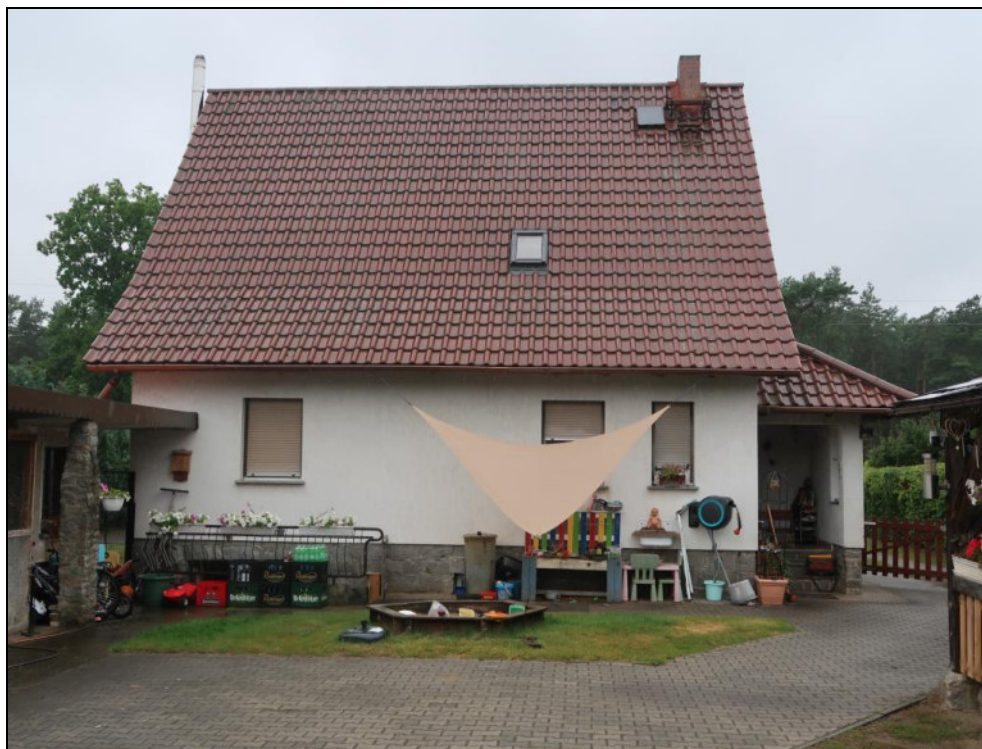
Bild 5: rückwärtige Gebäudeansicht des EFH
