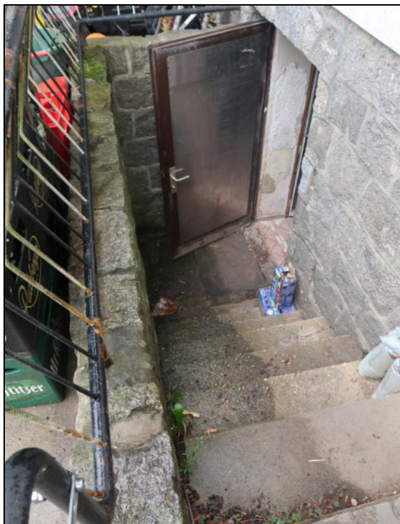
Bild 7: Kellerzugang an der Gebäuderückfront
