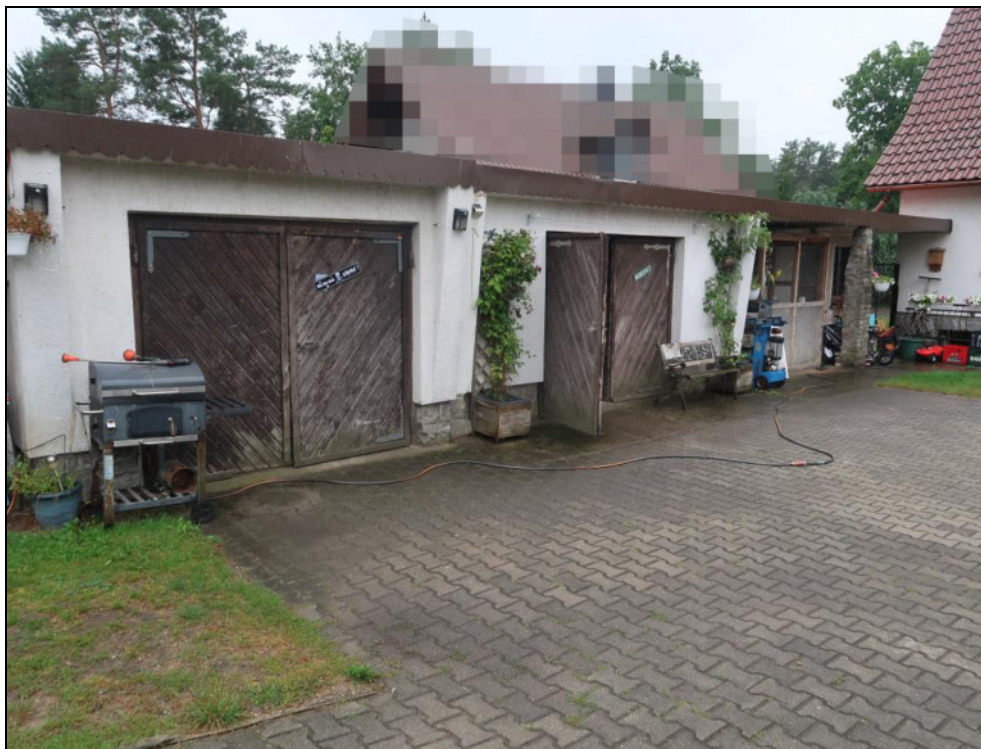
Bild 9: Hofansicht des Garagen- und Schuppengebäudes
