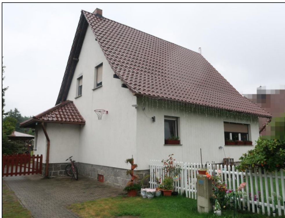
Bild 3: Vorderansicht von der Zufahrt
