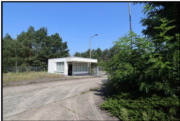
Süd-Ost-Ansicht des Pförtnergebäudes
