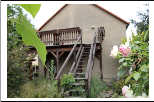
Ansicht des Wohngebäudes mit dem vorgebauten Balkon/Terrasse.
