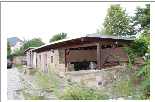
Ansicht des Schuppengebäudes auf dem Grundstück 1.
