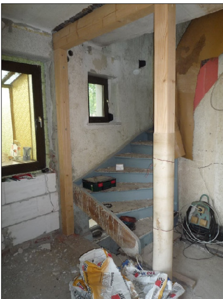
Wohnhaus, Erdgeschoss, Treppenhaus
