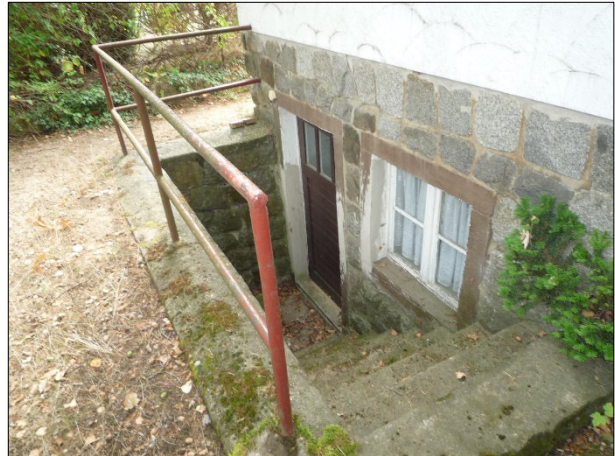
Hofansicht der Kelleraußentreppe des Wohnhauses
