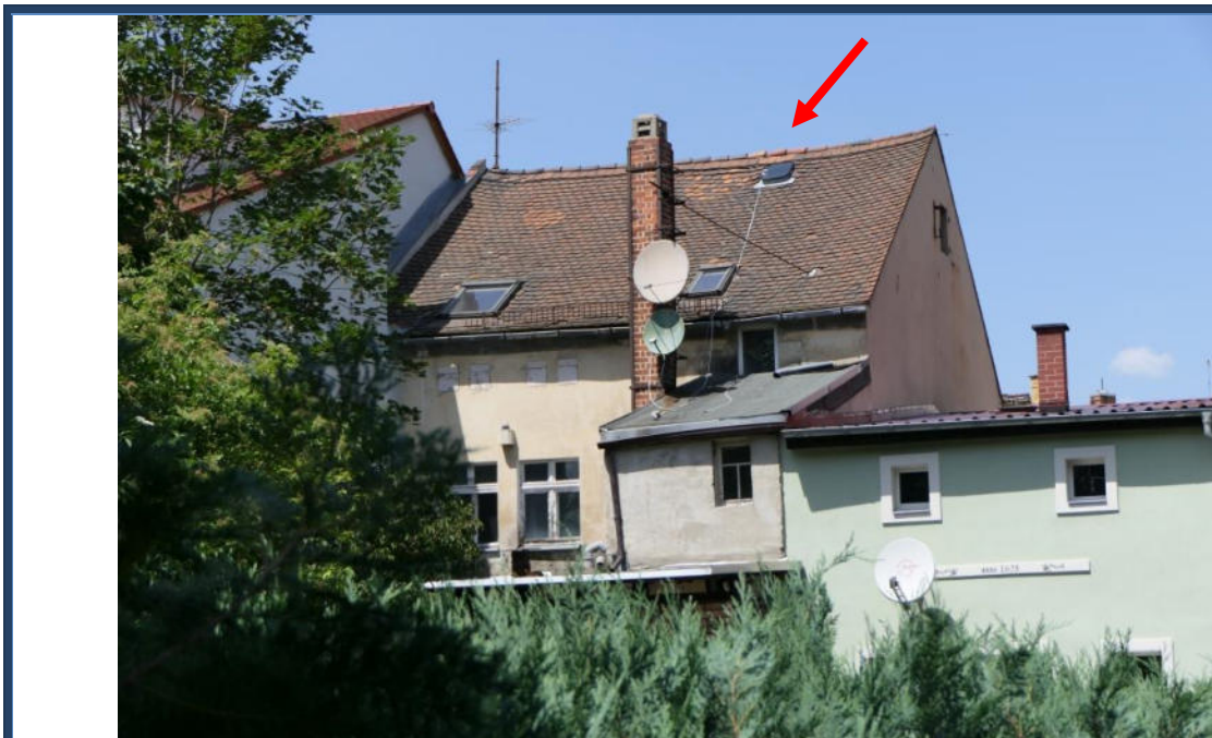
Abbildung 2: Rückansicht (Süd-Ansicht); angrenzende Bebauung
