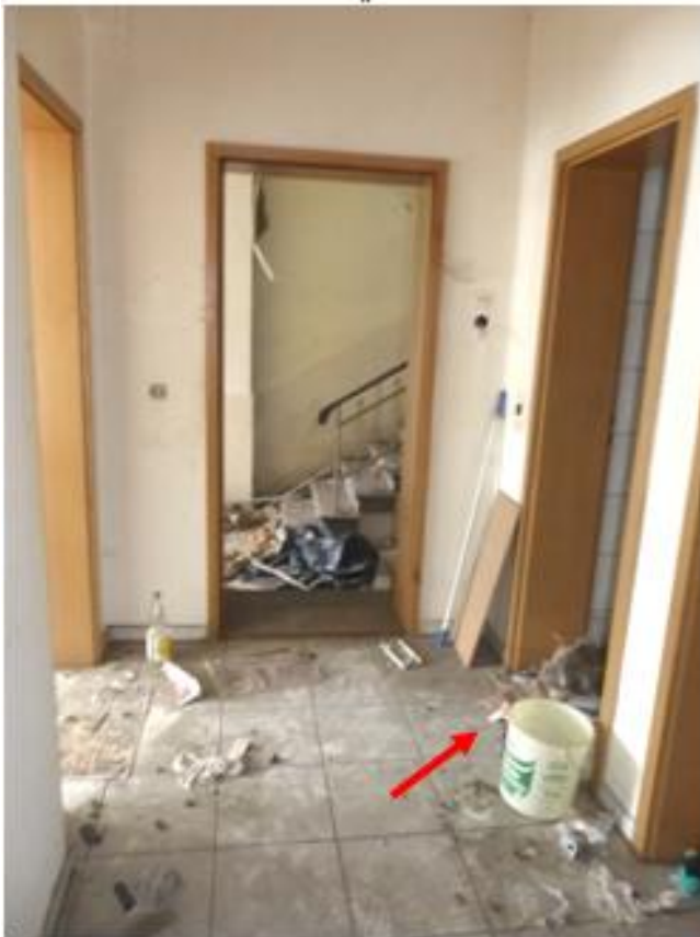
Wohnung Nr. 1 Flur mit Wohnungseingang
