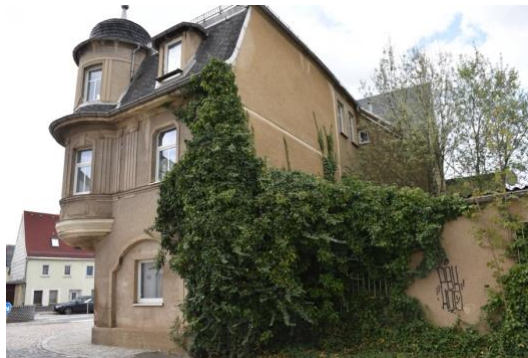
Foto 2: Südansicht Anbau mit benachbarten Vorderhaus
