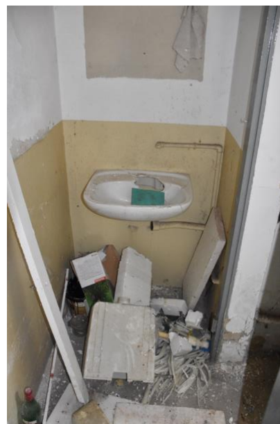
Foto 11: Innenfoto EG- Toilette
