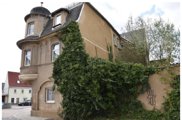
Foto 4: Südostansicht mit EG-Anbau als Überbau auf Flst: 1750
