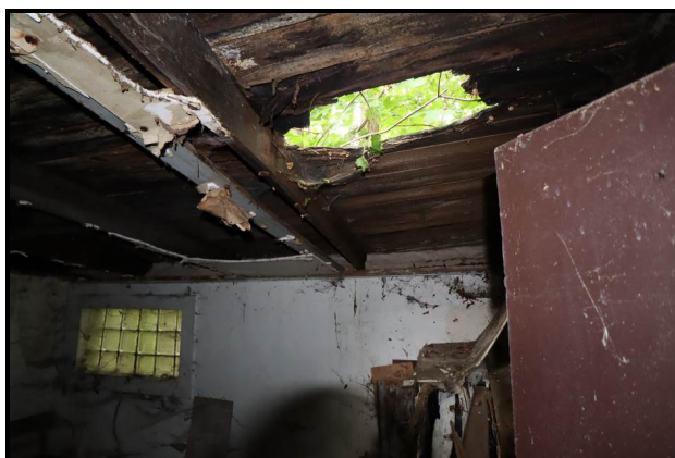
schadhaftes Dach
