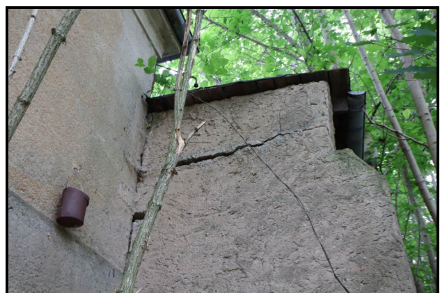
Detailansicht Mauerwerksrisse
