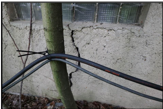
Detailansicht Mauerwerksrisse
