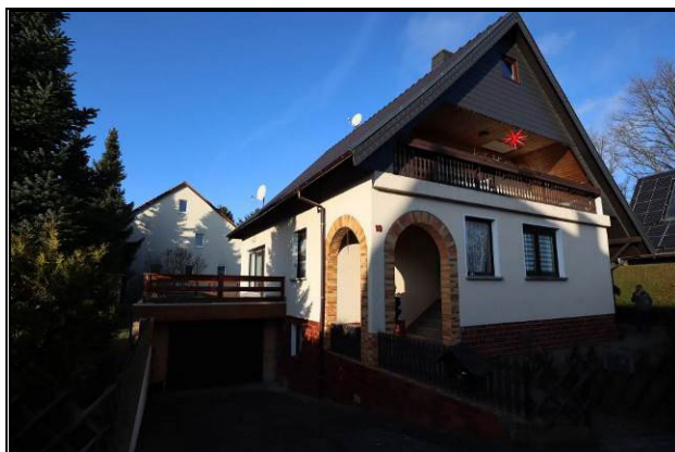
Süd-Ost-Ansicht des Wohnhauses
