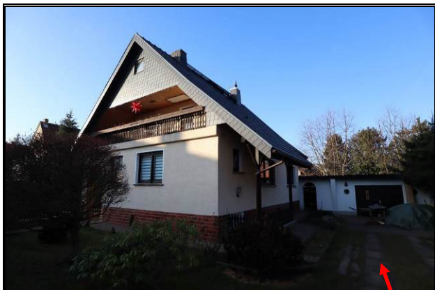
Nord-Ost-Ansicht des Bewertungsobjekts; Grundstückszufahrt
