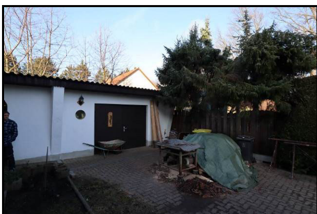
Süd-Ost-Ansicht der freistehenden Garage
