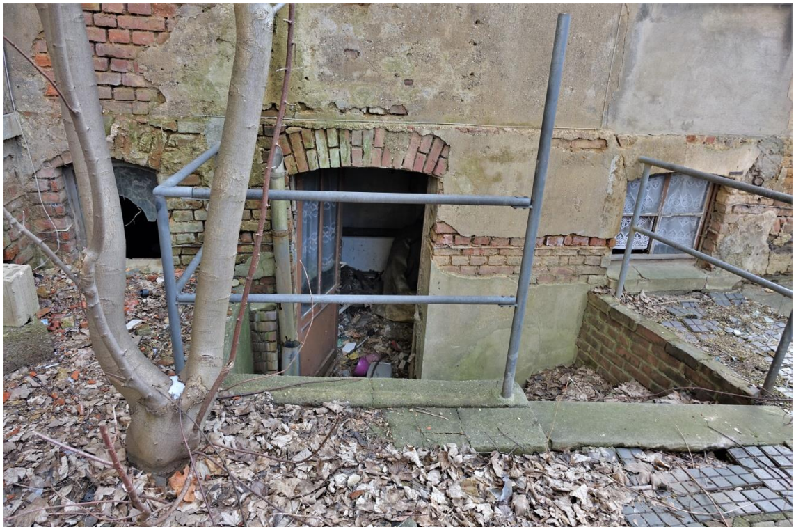
Wohn-/Geschäftshaus, unterer Bereich mit Waschküchenzugang, NNW-Ansicht
