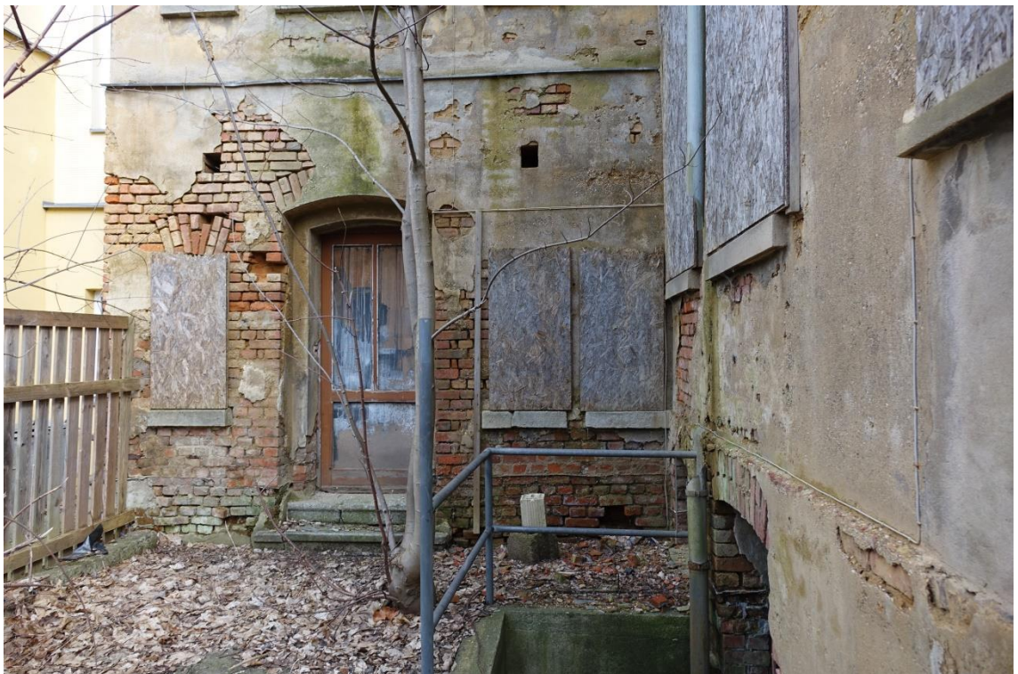
Wohn-/Geschäftshaus, hofseitige Zugangstüre zum Treppenhaus, WSW-Ansicht
