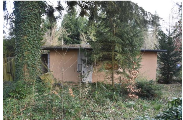
Foto 4: Nordwestansicht des Gartenhauses mit außen liegendem Elektroanschluss
