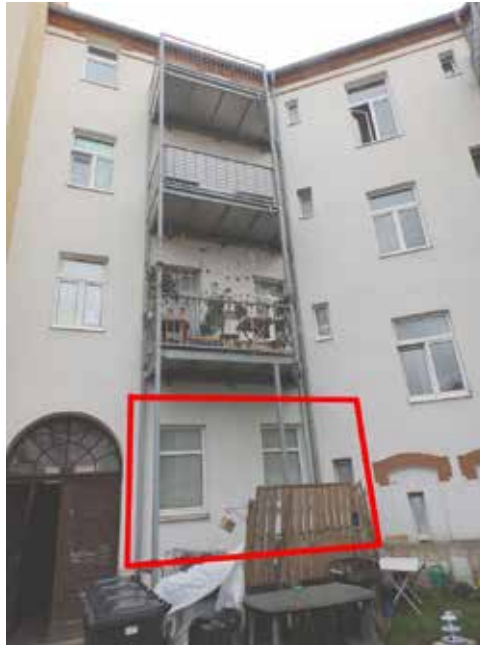
Bild 7: Rückansicht des Wohn- und Geschäftshauses (mit Kennzeichnung der Lage des Sondereigentums)
