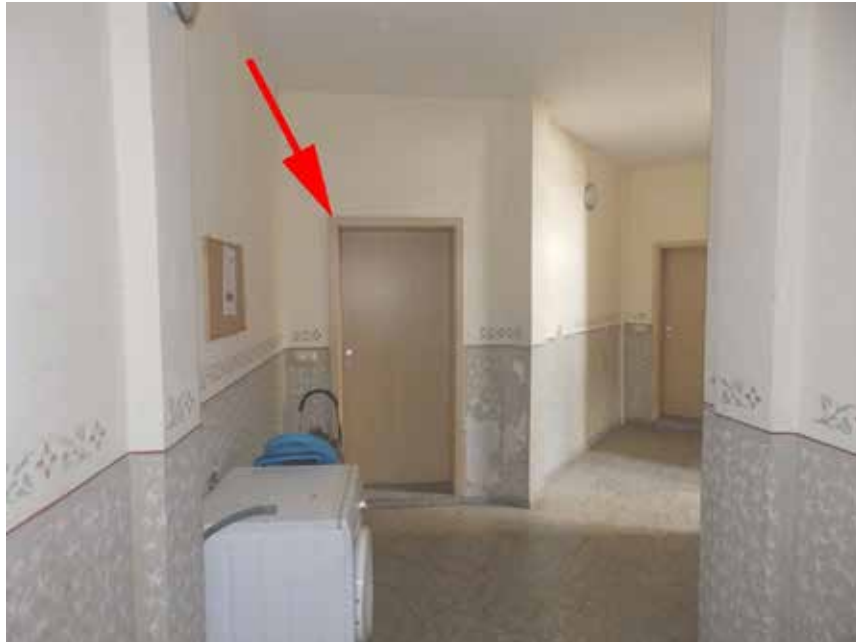
Bild 9: Treppenhaus (mit Eingang zum Sondereigentum -Laden-)
