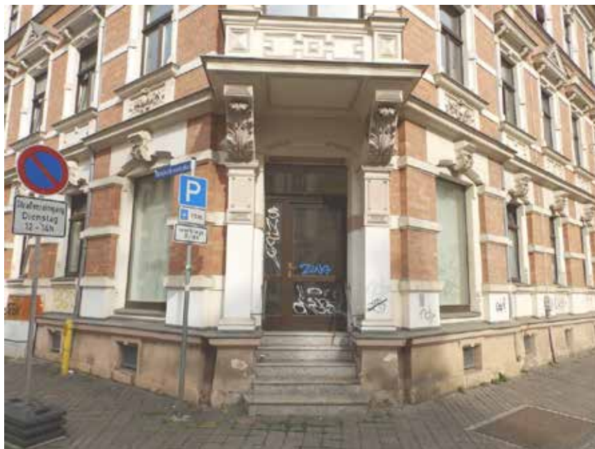
Bild 4: Detailansicht des Wohn- und Geschäftshauses (mit Eingang zum Sondereigentum)
