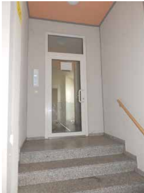
Bild 8: Eingang zum Treppenhaus
